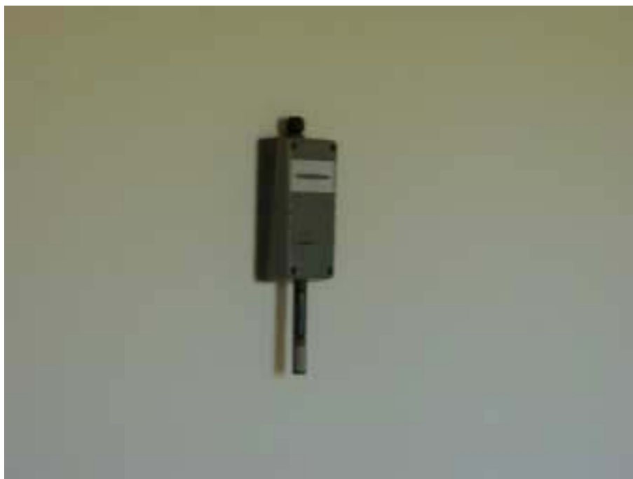
Figure 55 Sonde température – hygrométrie intérieure
