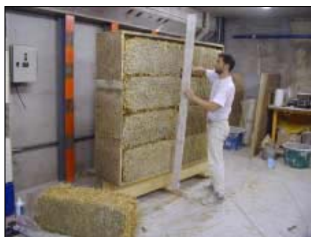
Figure 16 Vérification : la planéité est maintenant satisfaisante
