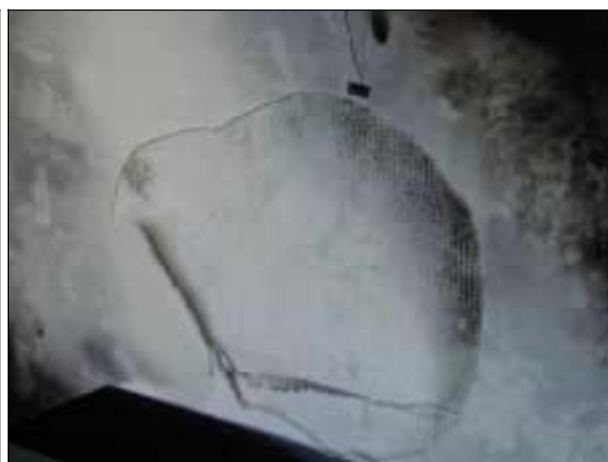
Figure 40 - La couche extérieure de l'enduit a cloqué, laissant voir la trace de l'armature
