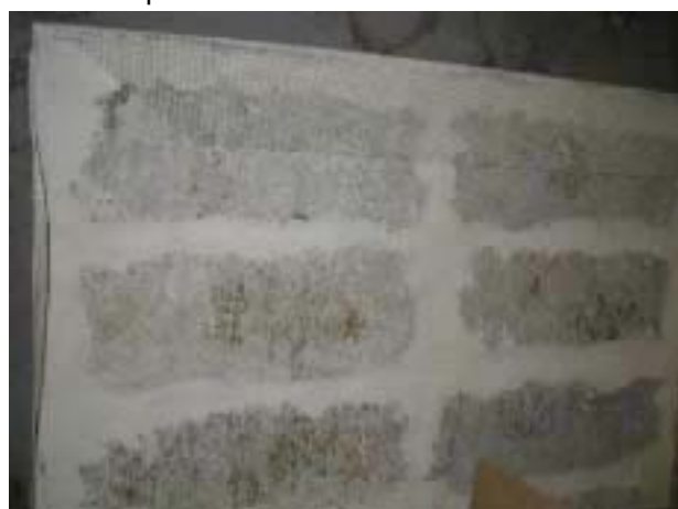
Figure 20 Mur paille avant enduits
