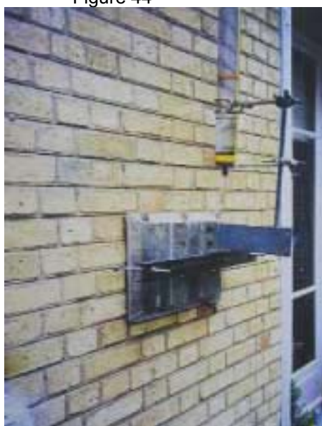
Principe de l'essai sur un mur de brique
