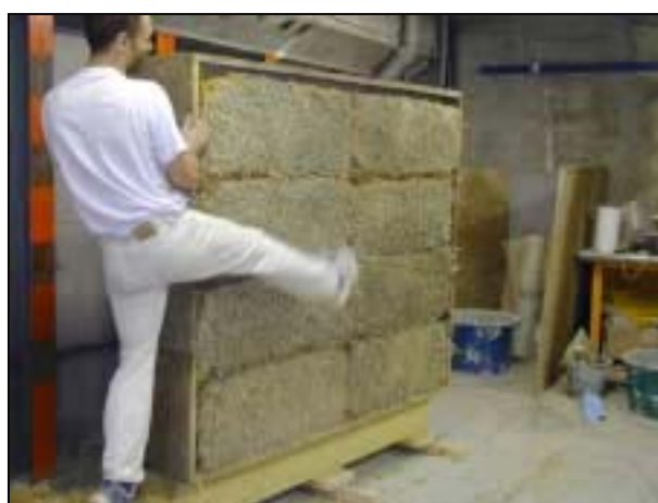
Figure 16 Vérification : la planéité est maintenant satisfaisante
