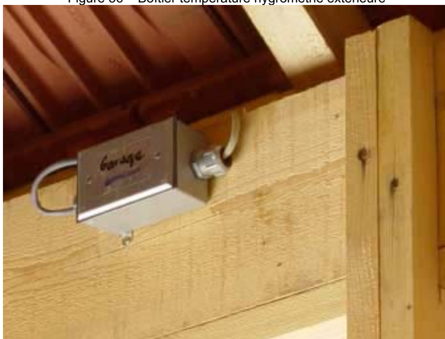
Figure 56 – Boîtier température hygrométrie extérieure
