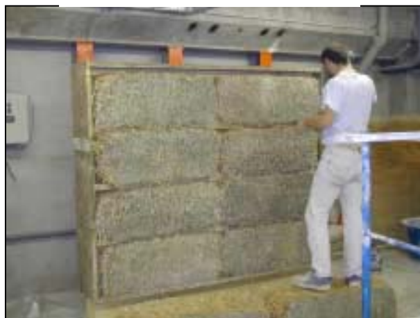
Figure 14 Rectification de la position des bottes
