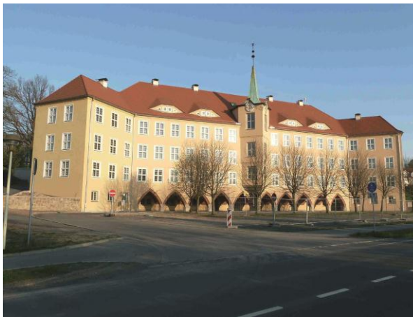
Bild 1: Nordwest-Ansicht des sanierten Gebäudes
