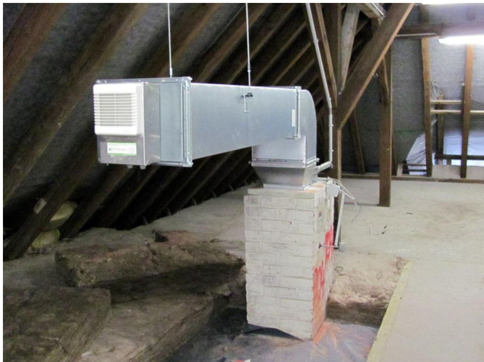
Bild 29: Reaktivierter Abluftschacht mit nachgerüstetem Schalldämpfer im Dachstuhl
