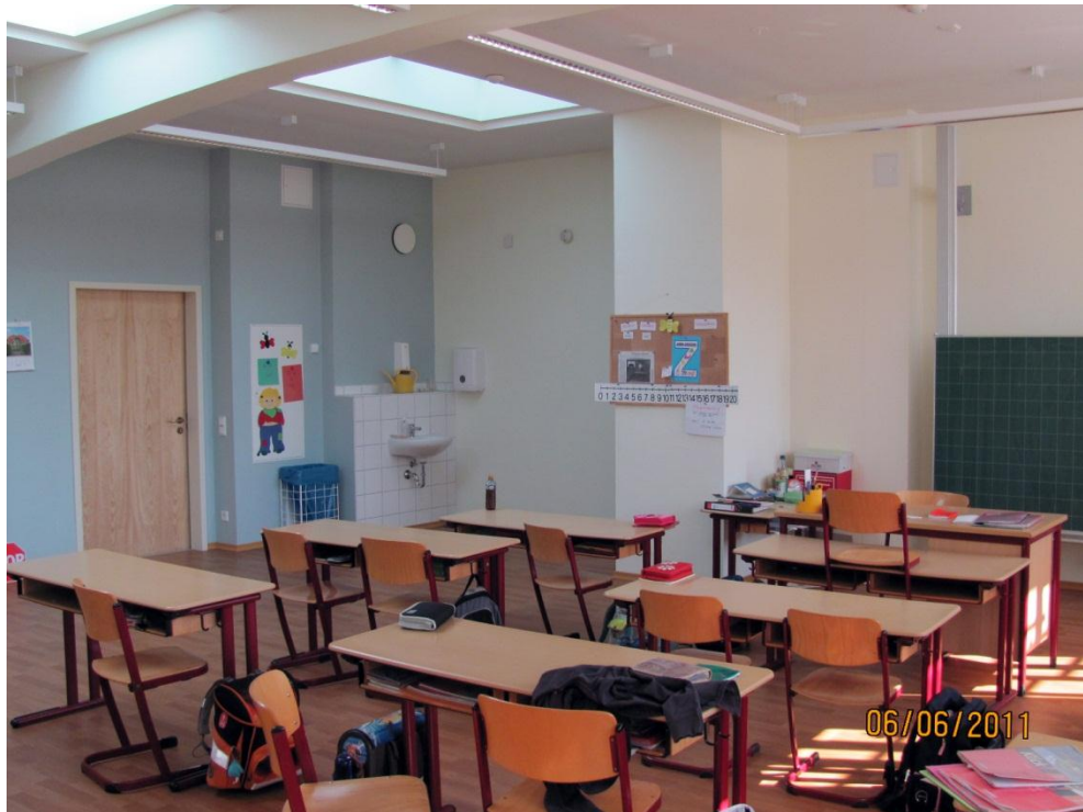
Bild 23: Erhöhung des natürlichen Tageslichtanteils in den hinteren Bereichen der Klassenzimmer Auch Bereiche nahe oder unter Niveau des Erdbodens konnten über den neuen Lichtgraben natürlich belichtet werden.
