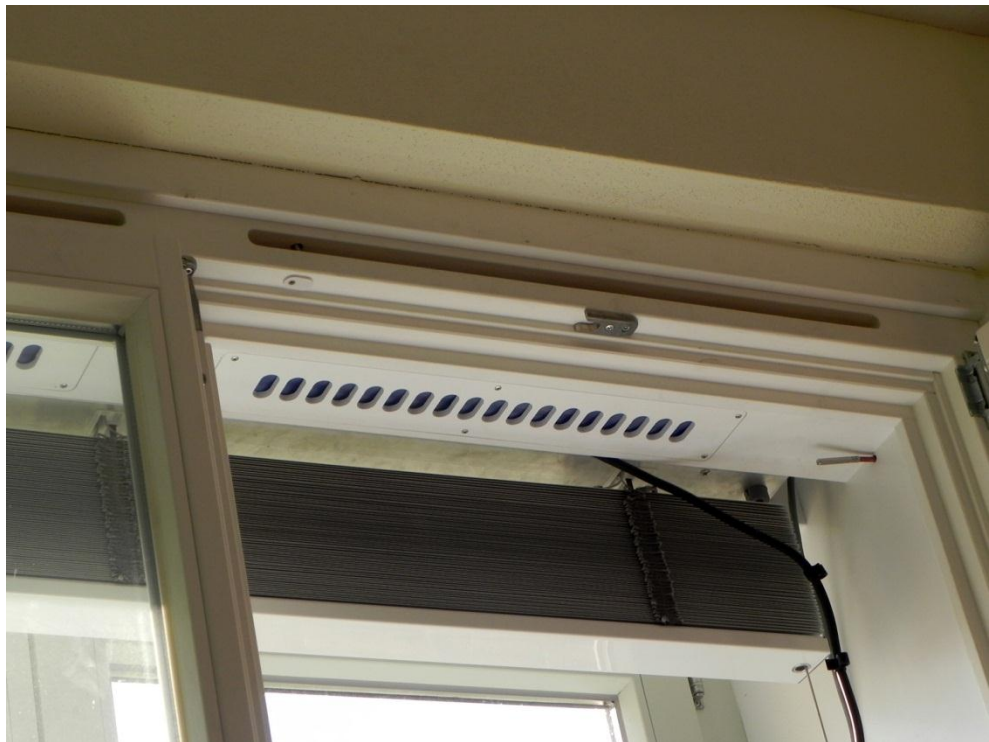
Bild 19: Zuluftöffnungen am inneren Fensterrahmen mit integrierten Rückschlagklappen
