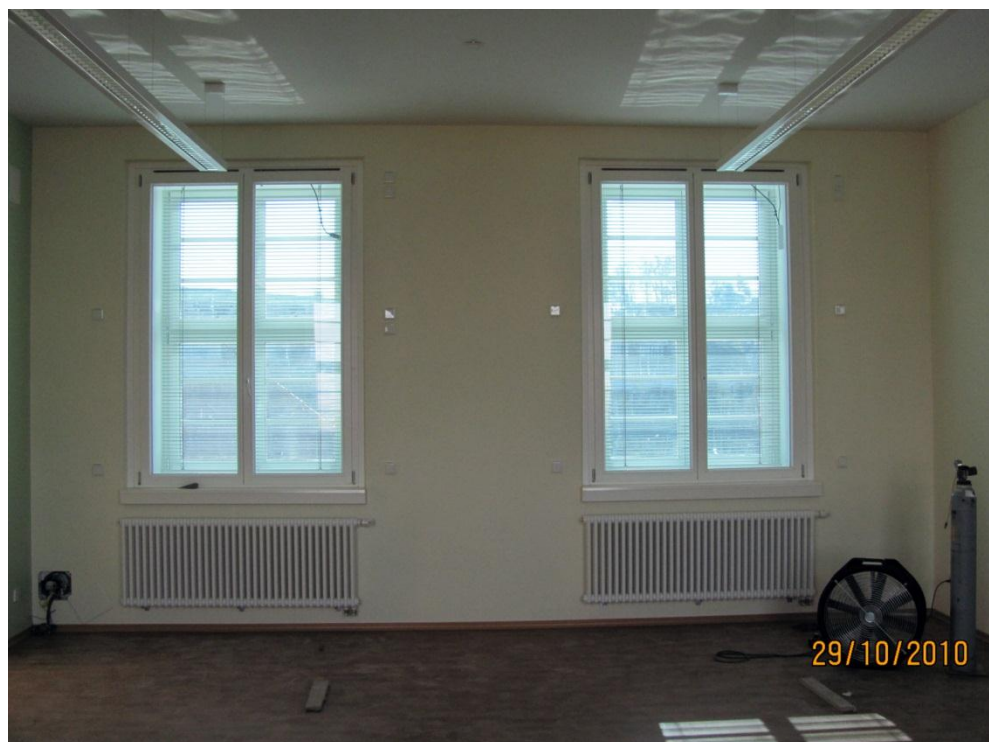
Bild 21: Zuluft-Kastenfenster mit Lichtlenkung
