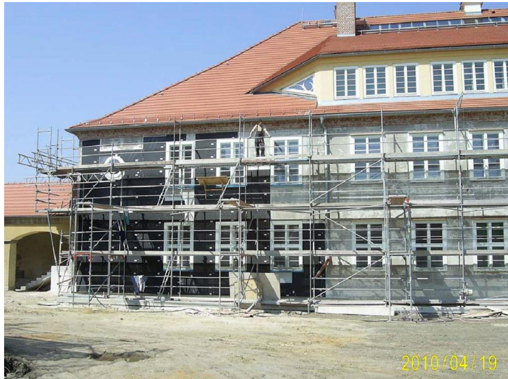
Bild 16: Montage der Vakuumdämmpaneele an der Südostseite der Fassade
