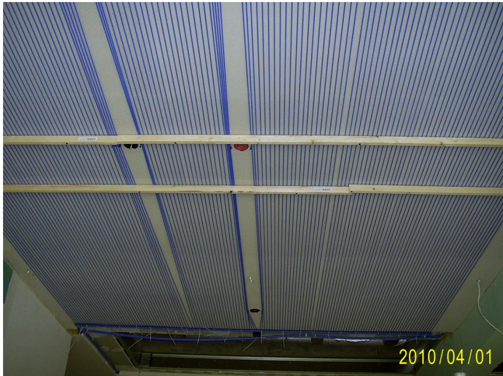
Bild 25: Kapillarrohrmatten zur passiven Kühlung
