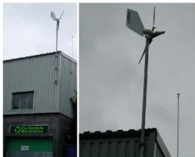
Obrázok B.9 Mikroturbína Ampair s výkonom 600 W. Priemerná energia vyrobená touto mikroturbínou v kúpeľoch v Leamingtone je 0,037 kWh za deň (1,5 W).
