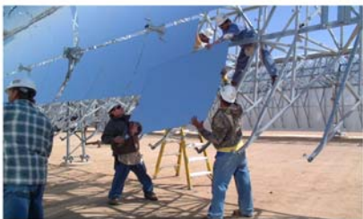
Obrázok 25.4 Andasol – rozostavaná „100 MW“ solárna elektrárňa v Španielsku. Nadbytočné teplo vyrobené cez deň sa uloží v nádržiach s tekutou soľou až na sedem hodín a zásobuje sieť nepretržitým a stabilným elektrickým výkonom. Elektrárňa by mala podľa predpokladov vyrábať 350 GWh za rok (40 MW). Parabolické žlaby zaberajú 400 hektárov, preto výkon na jednotku plochy krajiny bude 10 \text{ W/m}^2 . Horná fotografia: ABB. Nižšia fotografia: IEA SolerPACES.
