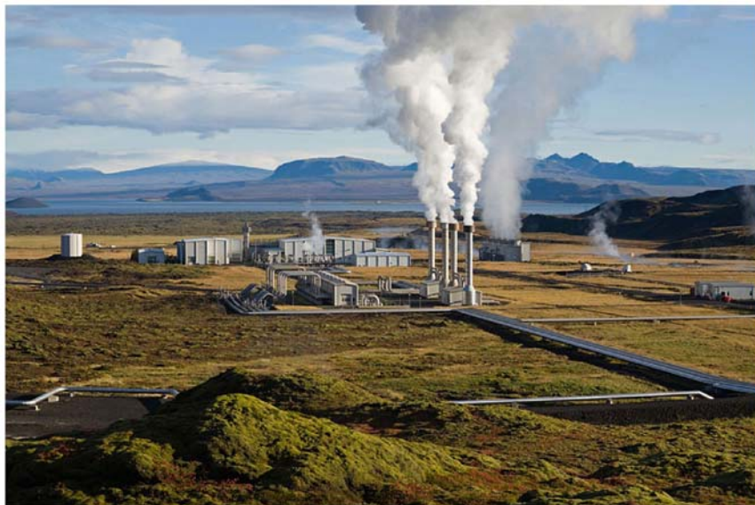
Obrázok 16.3 Geotermálna elektrárň na Islande. Priemerný elektrický výkon zo zemského tepla na Islande (populácia 300 000) v roku 2006 bol 300 MW (24 kWh/d na osobu). Viac ako polovica elektriny Islandu sa spotrebuje na výrobu hliníka. Fotografia: Gretar Ívarsson.
