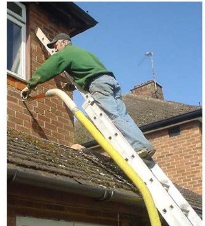
Obrázok 21.5 Tepelná izolácia stien z dutých tehál.
