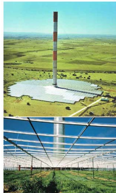
Obrázok 25.10 Prototyp solárnej komínovej elektrárne v Manzanarese. Fotografie: solarmillennium.de.
