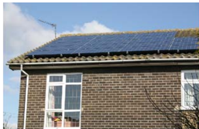
Obrázok 6.5 Fotovoltaika: hodnoty z plochy 25 m 2 v Cambridgeshire v roku 2006. Maximálny výkon je 4 kW. Celoročný priemer je 12 kWh za deň. To je 20 W na štvorcový meter panelu.
