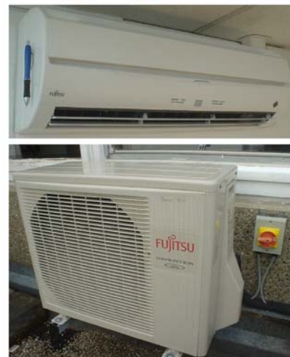
Obrázok 21.11 Vnútorne a vonkajšie časti tepelného čerpadla využívajúceho teplo vzduchu s výkonovým číslom 4. Na vnútornej časti je zavesené guľôčkové pero na porovnanie veľkosti. Jedna z týchto jednotiek firmy Fujitsu dokáže dodať 3,6 kW tepla, pri spotrebe iba 0,845 kW elektriny. Môže fungovať aj opačne zabezpečujúc 2,6 kW chladu pri spotrebe 0,655 kW elektriny.
