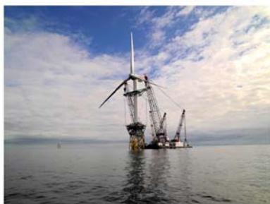
Obrázok 10.8 Stavba Beatrice, ukážka veternej turbíny v hlbokých moriach. Fotografie poskytla Talisman Energy (UK) Limited.
