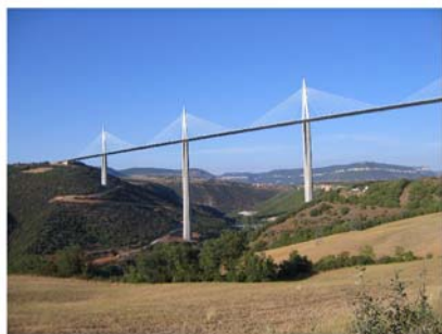
Obrázok H.7 Viadukt Millau vo Francúzsku, najvyšší most na svete. Je z ocele a betónu, 2,5 km dlhý a 353 m vysoký.
