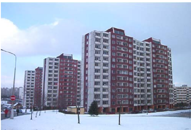
obr. 3. Panelový dům bez zateplení – Bystrc
