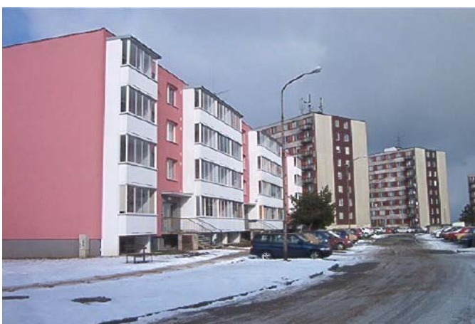
obr. 2. Panelové domy s různým typem zateplení – Kohoutovice
