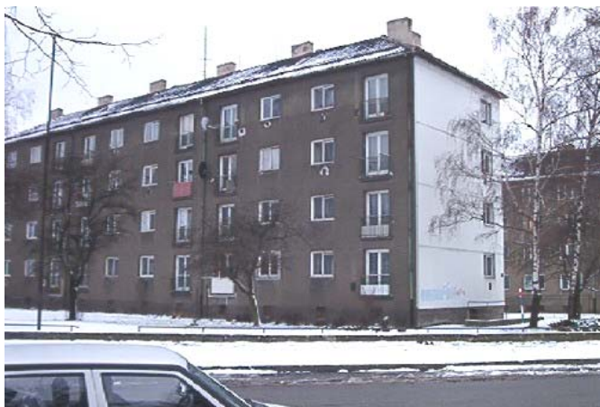
obr. 4. Bytová zástavba cihlová, staršího typu – zateplené štíty – Stará Osada
