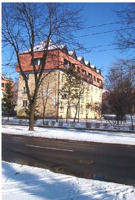
obr. 5. Bytová zástavba cihlová, staršího typu – bez zateplení s nástavbou – Slatina
