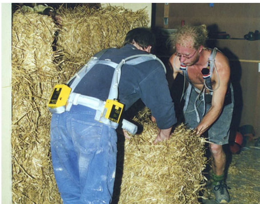
Figur 52. Måling af støv- og svampesporerpotentiale ved opbygning af halmvægge på By og Byg.
