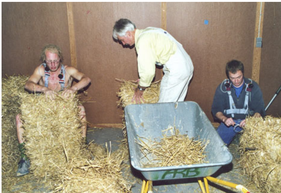
Figur 54. Tildannelse og syning med bindegarn.
