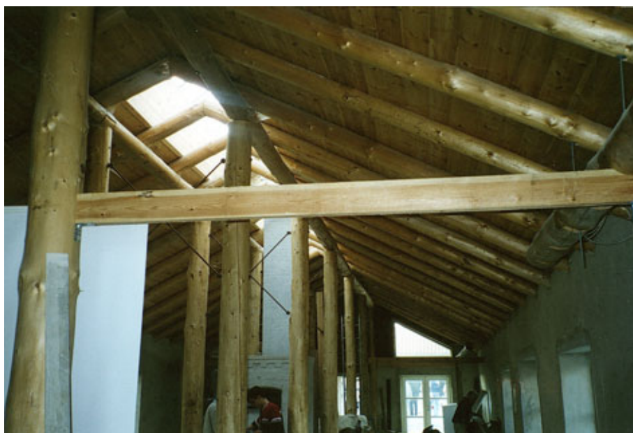
Figur 7. Munksøgårdbebyggelsens fælleshus under opførelsen i 2000. Huset er opbygget som et langskib med bærende konstruktioner i afbarket fuldtømmer. Ovenlyset og de trekantede gavlvinduer understreger konstruktionens opbygning.
