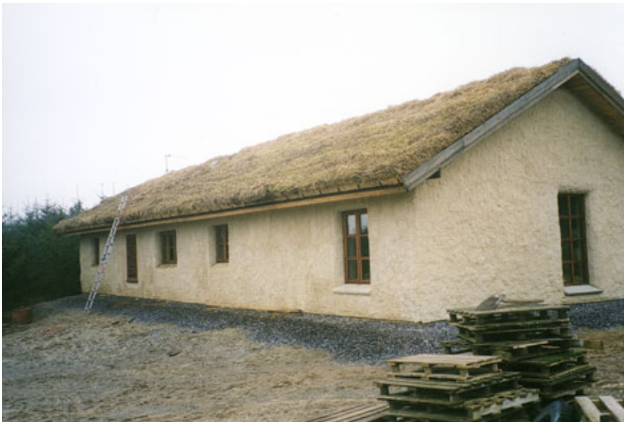
Figur 8. Halmhus i Pandrup i Vendsyssel opført i 1999. Det vinkelformede halmhus er brutto 356 m 2 , hvoraf 160 m 2 er beboelse (billedet). De resterende 96 m 2 er garage og fyrrum. Halmhuset er opført af selvbyggere. Bygningen har et bærende skelet af rundtømmer og stålstoelper. Den udvendige puds er en blanding af kalk og lerjord.
