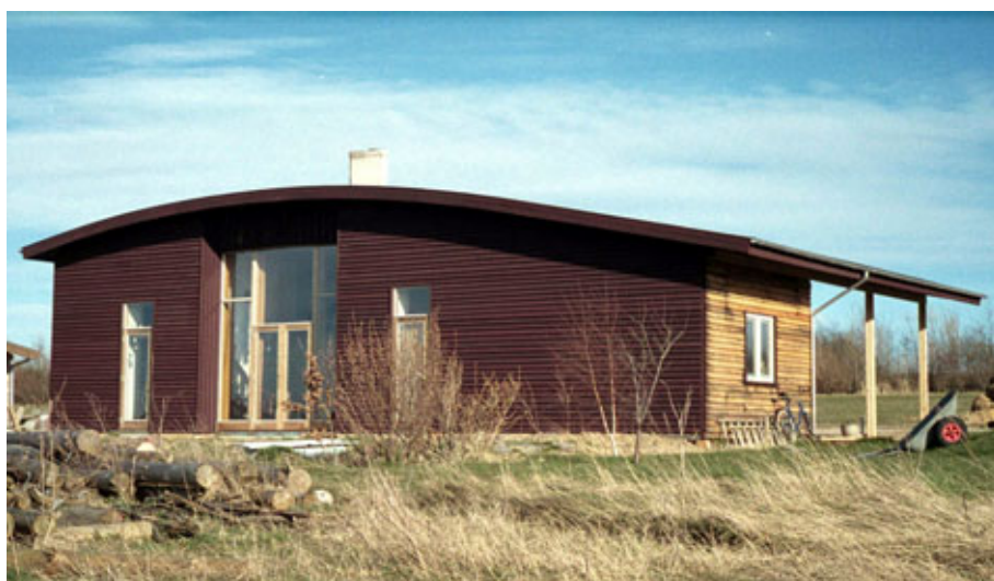
Figur 1. Halmhus i Herskind ved Århus. Huset er opført i 2001 af professionelle håndværkere. Udenpå de lerpudsede halmvægge er opsat en regnskærm af brædder på klink. Stålpilader er anvendt som tagdækning, og hensigten er, at der skal græs på taget. (Foto: Jettie Nielsen).
