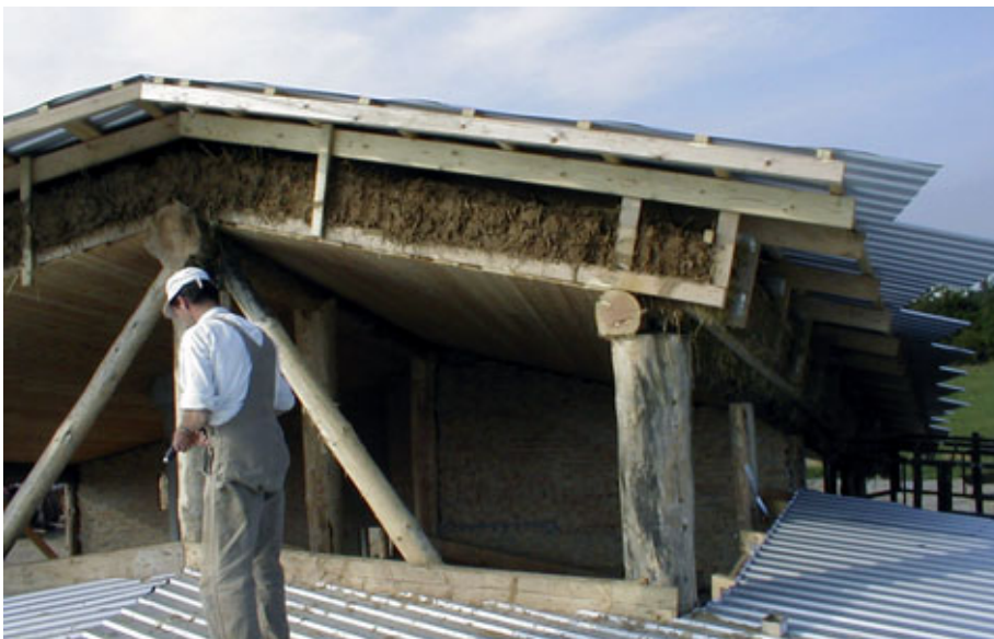
Figur 17. Halmhus i Herskind ved Århus under opbygning. Afstivning af gavl og tagkonstruktion. (Foto: Lars Keller).
