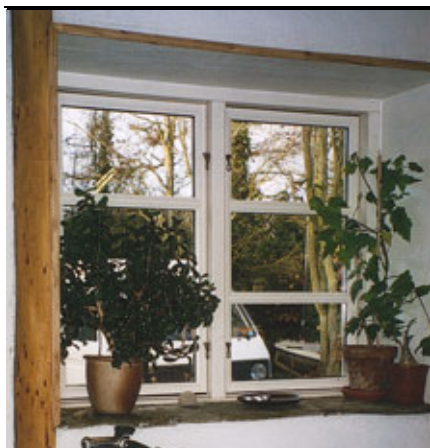
Figur 11. Halmhus i Vester Skerninge på Sydfyn har gode dagslyshforhold, da tagudhænget ikke skygger for lysindfald.
