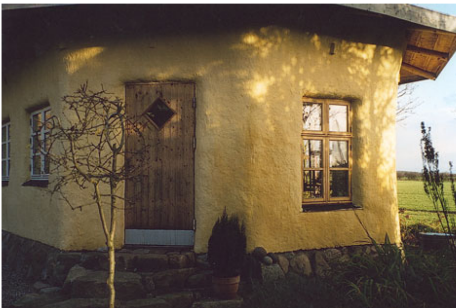
Figur 10. Halmhus og keramikværksted i Vester Skerninge på Sydfyn opført i 2000 af selvbyggere som et led i undervisning og byggeworkshop i, hvordan man bygger halmhuse. Halmhuset er ét stort ottekantet rum på knap 50 m 2 med bærende konstruktioner i rundtømmer. Væggene er pudset med lermørtel såvel ude som inde. Kalken er indfarvet med jordpigmentet okker.
