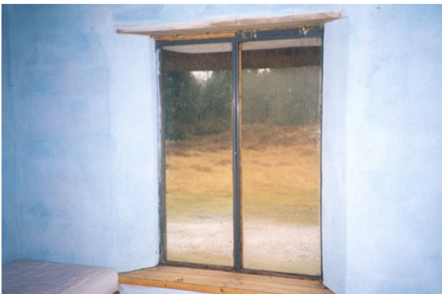
Figur 24. Det ses, at tagudhænget tager en del lys, og at det er nødvendigt at afstemme vinduesoverkanten med tagudhængets placering og omvendt for at få bedst mulig lysindfald. Vindueslysningerne er til gengæld udformet, så der kommer mest mulig lys ind i rummet. Lerpudsens er tilsat blåt pigment. Interiør fra halmhus i Sdr. Felding.
