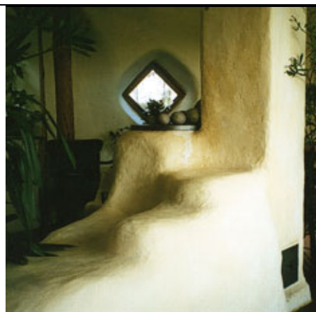
Figur 12. Halmhus i Vester Skerninge på Sydfyn. Centralt placeret i halmhuset kan en masseovn forsyne hele rummet med varme og bænken med.
