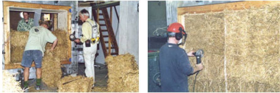
Figur 42. Opbygning og afretning af halmvægge med vinkelsliber i forbindelse med opbygning af Varm-kold kasse på By og Byg beregnet til test af fugtphobning.
