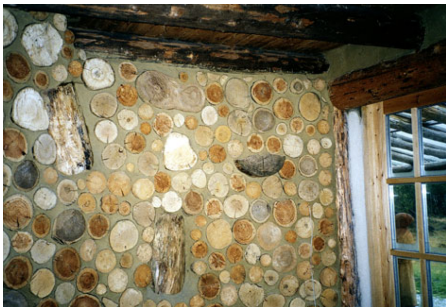
Figur 25. Væg fra halmhus i Sdr. Felding. Ubrændt ler og endetræ er gode til at akkumulere fugt af betydning og dermed reducere udsving i luftfugtigheden. Svind af både træ og ler betyder, at der nemt opstår sprækker omkring træet.
