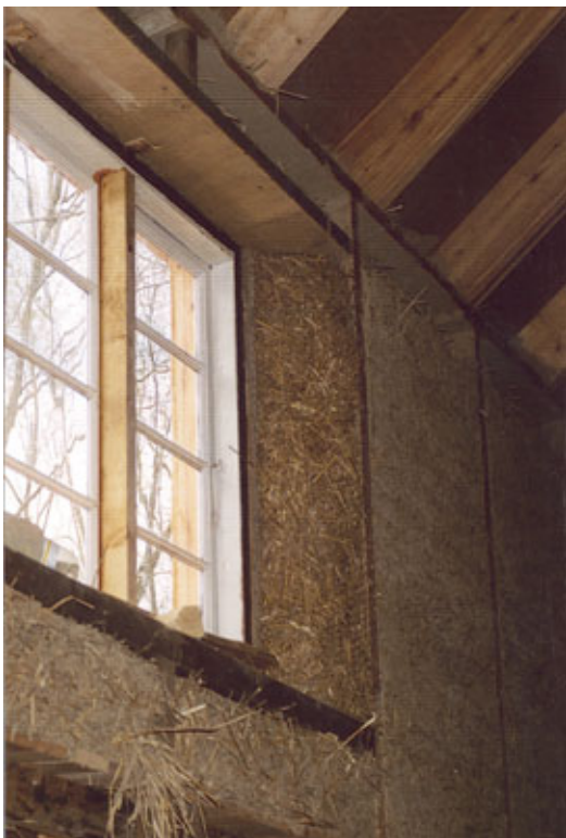
Figur 23. Afrundet vindueslysning hvor halmen er fastholdt med kyllingenet. Halmhus i Agerup ved Næstved.
