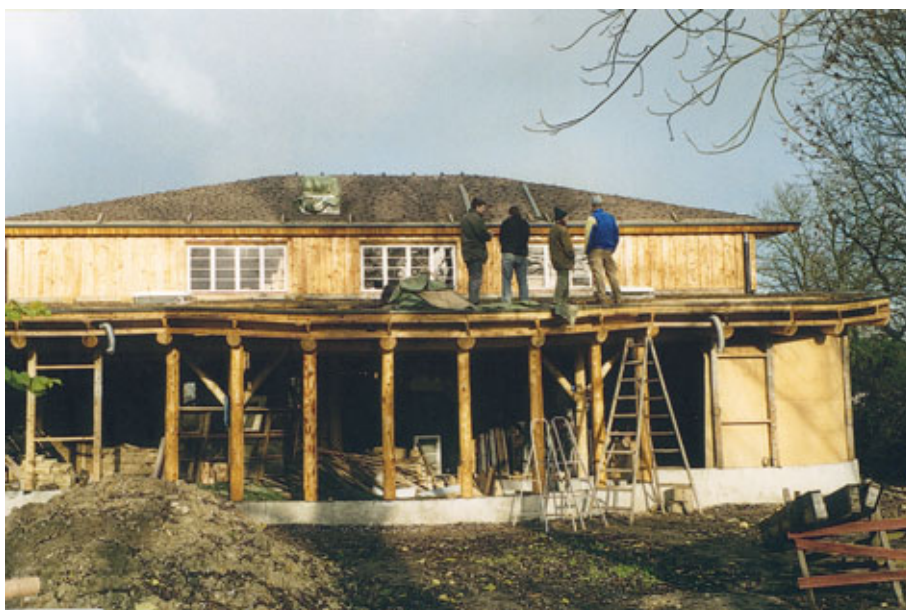
Figur 13. Halmhus i Agerup ved Næstved opført i 2002 af selvbyggere. Byggeriet er inspireret af tyske ler- og halmbyggeteknikker. Der er fx fremstillet lerhalmplader på stedet til indervægge, og i etageadskillelsen er der anvendt lyddæmpende viklere (ler snoet omkring lægter).
