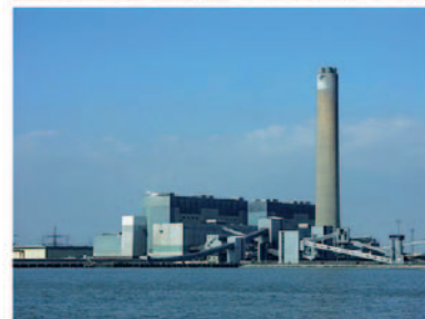
Obrázok 23.1 Uhlie dopravované do elektrárne v Kingsnorthe (výkon 1 940 MW) v roku 2005. Autor fotografie: Ian Boyle www.simplonpc.co.uk .
