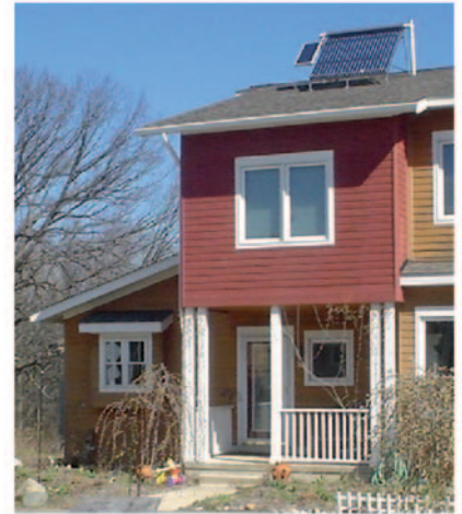
Obrázok 30.2 Solárne tepelné kolektory, ktoré zabezpečujú prípravu teplej vody pre rodinu v Michigane. Obehové čerpadlo systému poháňa elektrina z malého fotovoltaického panelu naľavo.
