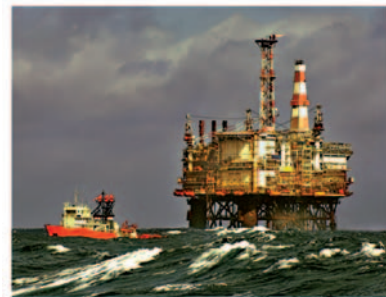
Obrázok 10.4 Plošina Magnus v severnom britskom sektore v Severnom mori obsahuje 71 000 ton ocele. V roku 2000 táto plošina vyťažila 3,8 milióna ton ropy a plynu – výkon 5 GW. Stála 1,1 miliardy libier. Fotografie: Terry Cavner.
