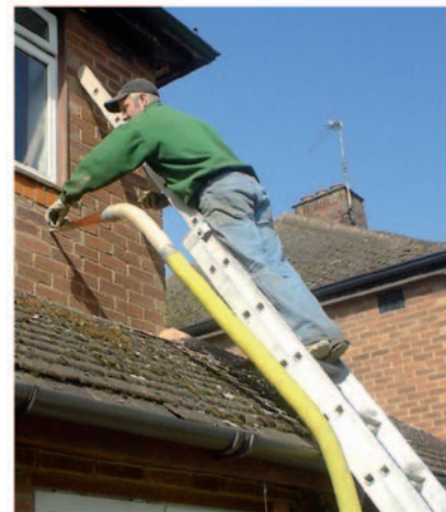
Obrázok 21.5 Tepelná izolácia stien z dierovaných tehál.
