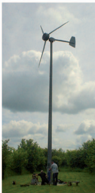
Obrázok B.10 Turbína Iskra s výkonom 5 kW a priemerom 5,5 pri ročnej revízii [www.iskrawind.com]. Táto turbína umiestnená v Hertfordshire (ktorý nepatrí medzi najveternejšie lokality vo Veľkej Británii), s výškou 12 m priemerne vyrobí 11 kWh za deň. Veterný park s turbínami s takouto výrobou s plochou 30 m × 30 m by mal koncentráciu výkonu 0,5 W/m 2 .
