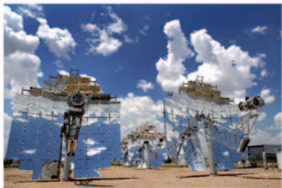
Obrázok 25.3 Stirlingov motor s tanierovitým zrkadlom. Tieto nádherné koncentrátoary dodávajú plošný výkon 14 \text{ W/m}^2 . Fotografia s láskavým povolením: Stirling Energy Systems. www.stirlingenergy.com
