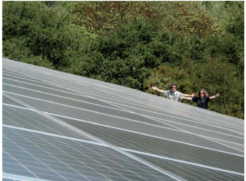
Obrázok 6.6 Dvaja solárni bojovníci sa tešia zo svojho fotovoltického systému, ktorý nabíja ich elektrické autá a dom. Súbor 120 panelov (každý 300 W s 2,2 m 2 ) má celkovú plochu 268 m 2 , maximálny výkon (po započítaní strát pri premene z jednosmerného na striedavý prúd (z DC na AC)) je 30,5 kWh/deň a priemerný výkon v Kalifornii, blízko Santa Cruz, je 5 kW (19 W/m 2 ). Fotografia poskytol Kenneth Adelman. www.solarwarrior.com .
