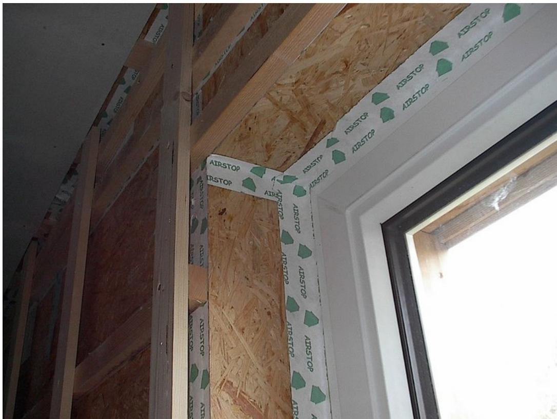
Viditelným materiálem domu je dřevo, z toho je též nosná konstrukce. Většinu objemu stěn ale tvoří balíky slámy. Na obrázku je detail utěsnění vnitřního obložení domu.
