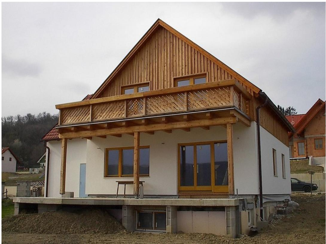
Dům v Breitenfeldu limit pasivního domu mírně překračuje, stavitele se rozhodl použít levnější okna. Zajímavá je ale technologie stavby, kdy do dřevěné konstrukce byly vtlačeny balíky slámy. Ta izoluje stejně jako polystyrén, je ale mnohem levnější a nikdo nemusí přemýšlet, jestli jí není škoda. Naopak, čím více se jí do domu uschová, tím lépe, je to sklad uhlíku, který předtím obilí vychytalo z ovzduší.
