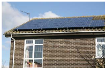
Obrázok 6.5 Fotovoltaika: hodnoty z plochy 25 m 2 v Cambrigheshire v roku 2006. Maximálny výkon je 4 kW. Celoročný priemer je 12 kWh za deň. To je 20 W na štvorcový meter panelu.
