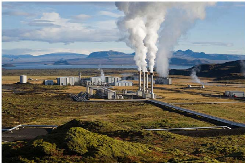
Obrázok 16.3 Geotermálna elektrárň na Islande. Priemerný elektrický výkon zo zemského tepla na Islande (populácia 300 000) v roku 2006 bol 300 MW (24 kWh/d na osobu). Viac ako polovica elektriny Islandu sa spotrebuje na výrobu hliníka. Fotografia: Gretar Ívarsson.
