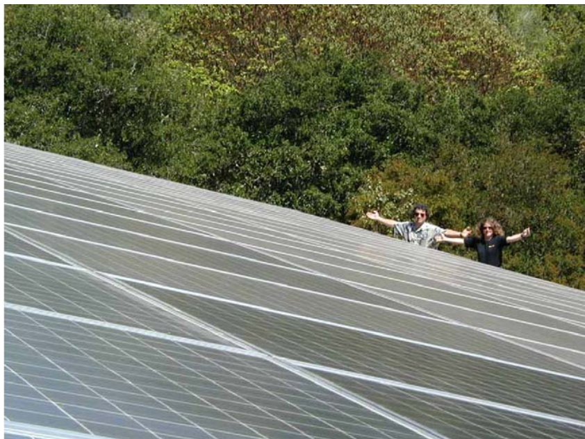
Obrázok 6.6 Dvaja solárni bojovníci sa tešia zo svojho fotovoltického systému, ktorý nabíja ich elektrické autá a dom. Súbor 120 panelov (každý 300 W s 2,2 m 2 ) má celkovú plochu 268 m 2 , maximálny výkon (po započítaní strát pri premene z jednosmerného na striedavý prúd (z DC na AC)) je 30,5 kWh/deň a priemerný výkon v Kalifornii, blízko Santa Cruz, je 5 kW (19 W/m 2 ). Fotografii poskytol Kenneth Adelman. www.solarwarrior.com .
