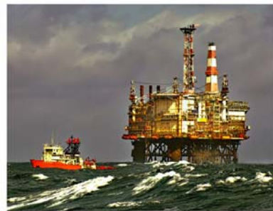
Obrázok 10.4 Plošina Magnus v severnom britskom sektore v Severnom mori obsahuje 71 000 ton ocele. V roku 2000 táto plošina vyťažila 3,8 milióna ton ropy a plynu – výkon 5 GW. Stála 1,1 miliardy libier. Fotografie: Terry Caver.
