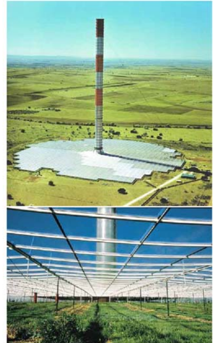
Obrázok 25.10 Prototyp solárnej komínovej elektrárne v Manzanarese. Fotografie: solarmillennium.de.
