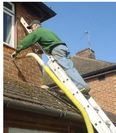
Obrázok 21.5 Tepelná izolácia stien z dutých tehál.
