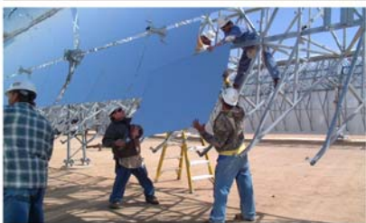
Obrázok 25.4 Andasol – rozostavaná „100 MW“ solárna elektrárň v Španielsku. Nadbytočné teplo vyrobené cez deň sa uloží v nádržiach s tekutou soľou až na sedem hodín a zásobuje sieť nepretržitým a stabilným elektrickým výkonom. Elektrárň by mala podľa predpokladov vyrábať 350 GWh za rok (40 MW). Parabolické žlaby zaberajú 400 hektárov, preto výkon na jednotku plochy krajiny bude 10 \text{ W/m}^2 . Horná fotografia: ABB. Nižšia fotografia: IEA SolerPACES.
