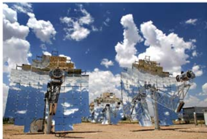
Obrázok 25.3 Stirlingov motor s tanierovitým zrkadlom. Tieto nádherné koncentrátoory dodávajú plošný výkon 14 \text{ W/m}^2 . Fotografia s láskavým povolením: Stirling Energy Systems. www.stirlingenergy.com
