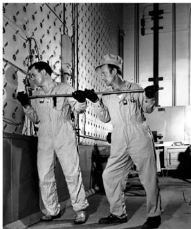
Obrázok 24.3 Pracovníci zasúvajú uránové valce do grafitového reaktora X-10.
