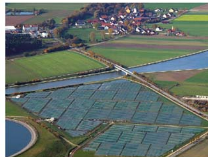
Obrázok 6.7 Solárna fotovoltaická elektrárň: 6,3 MW (maximum) Solarpark v Muhlhausene, v Bavorsku. Predpokladaný priemerný výkon je 5 W/m 2 . Fotografia: SunPower.
