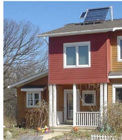
Obrázok 30.2 Solárne tepelné kolektory, ktoré zabezpečujú prípravu teplej vody pre rodinu v Michigane. Obehové čerpadlo systému poháňa elektrina z malého fotovoltaického panelu naľavo.
