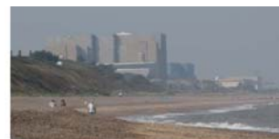
Obrázok 24.9 Jadrové elektrárne v Sizewell. Sizewell A, v popredí, mala výkon 420 MW. Odstavená bola na konci roku 2006. Sizewell B, vzadu, dosahuje výkon 1,2 GW. Fotografia: William Connolley.
