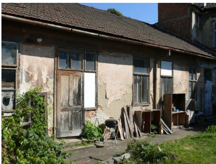
Táborská 30-dvorní křídlo společná část domu č.p. 3576
