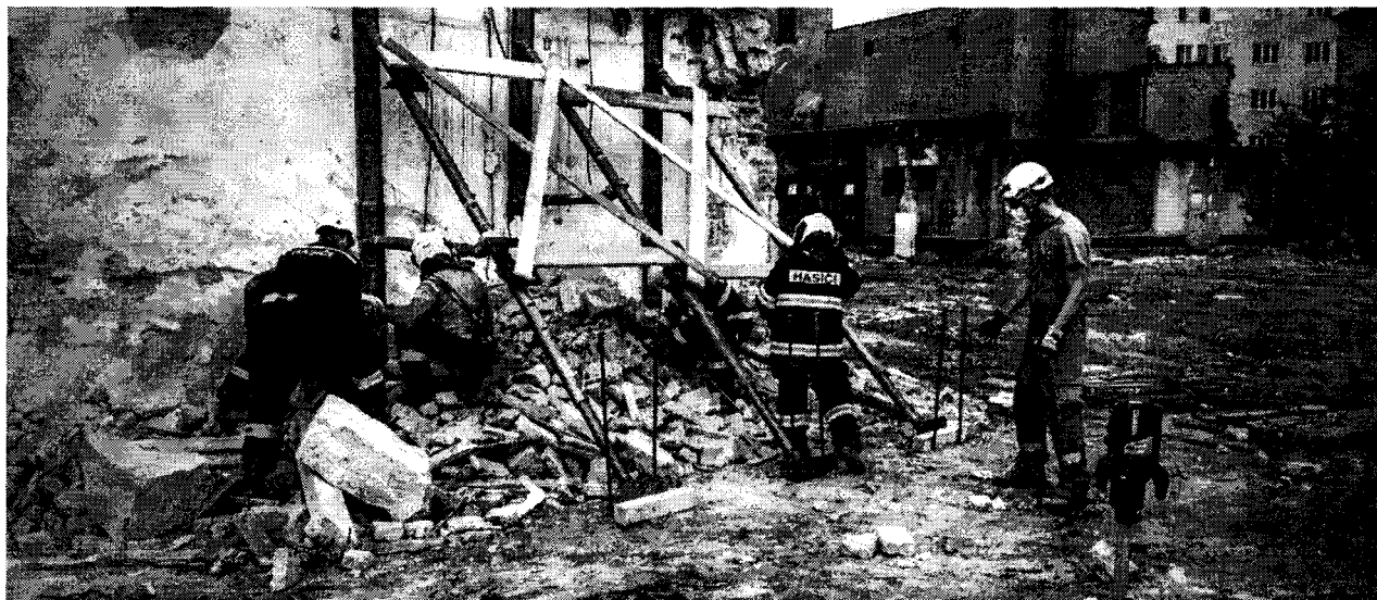
Výcvik specialistů na stabilizaci budov v areálu bourané Viněny.
