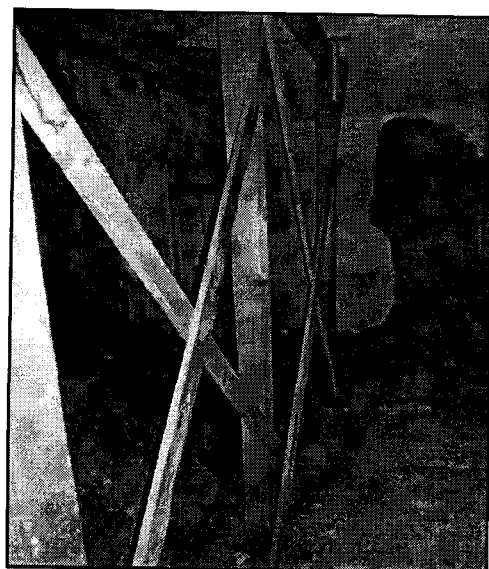
Podpřený strop v 1 NP
