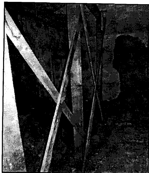
Podpřený strop v 1 NP
