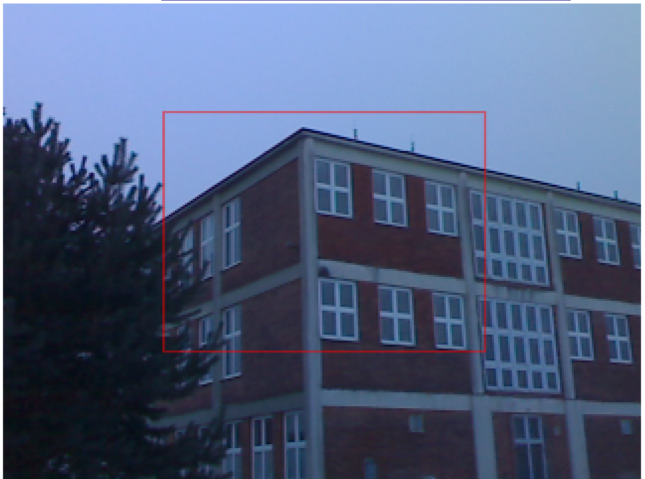
Druhé čelo budovy je chladnější, asi proto, že je chladněji i uvnitř.
