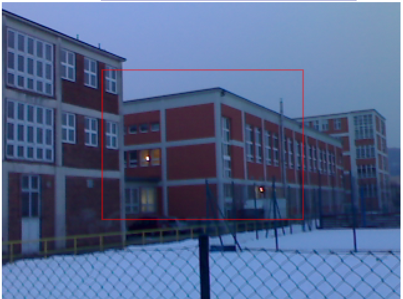
Druhá budova je zvenčí chladnější, až na větrací odvor u horního rohu a pootevřené okno.
