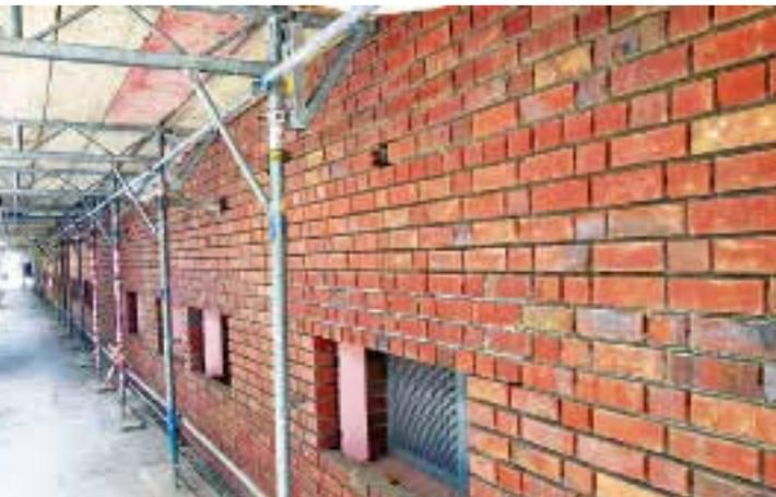
Backsteinfassade in drei Schichten: Alte Ziegel – Wärmedämmung – neue Ziegel | © complan Kommunalberatung
