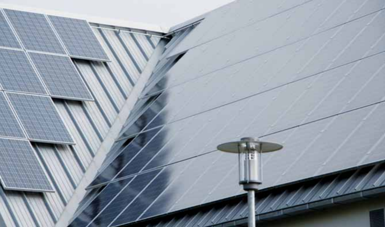
Neue Dachflächen nutzen
