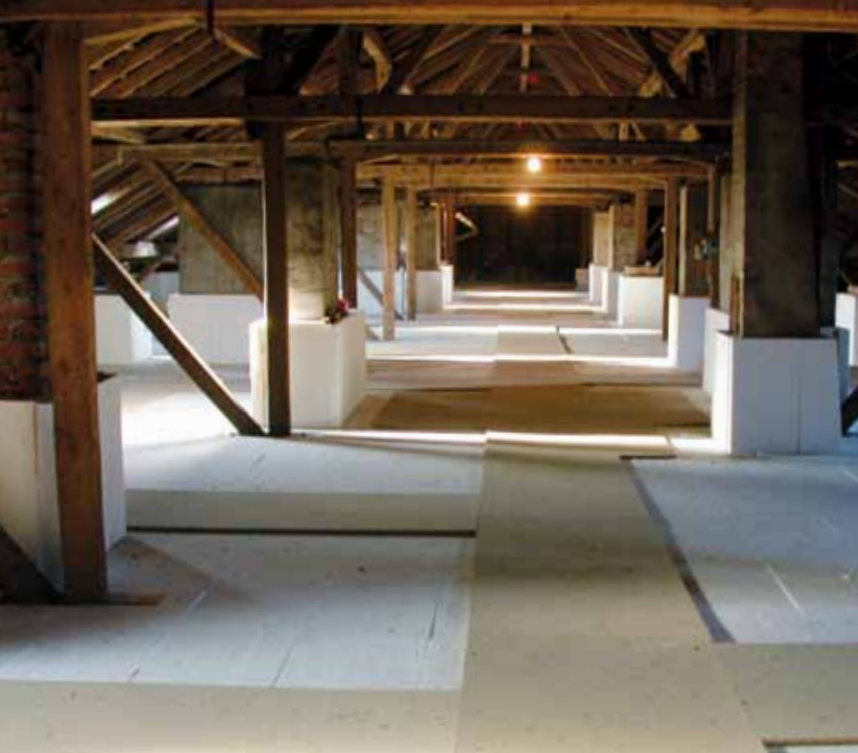
Dämmung der obersten Geschosdecke
