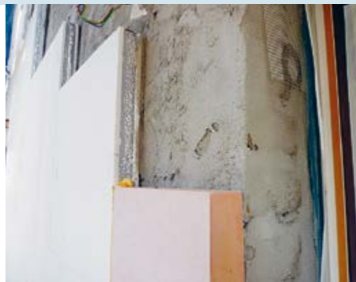
Ernst-May-Häuser, Donnersbergstraße, Frankfurt am Main, Wärmedämmung mit Vakuumisulationspaneele und Resol-Hartschaum
