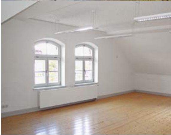
Kindertagesstätte Philipp-Koerber-Weg 2, nach Sanierung
