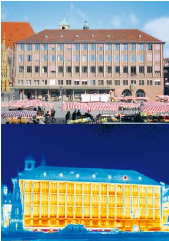
Neues Rathaus, Hauptmarkt 18, vor Sanierung
