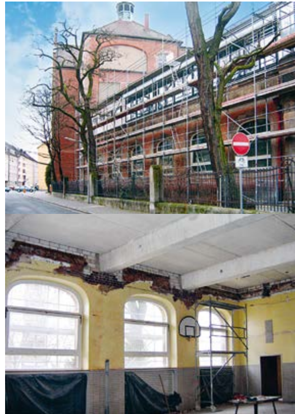
Turnhalle Volksschule, Schnieglinger Straße 38, während der Sanierung
