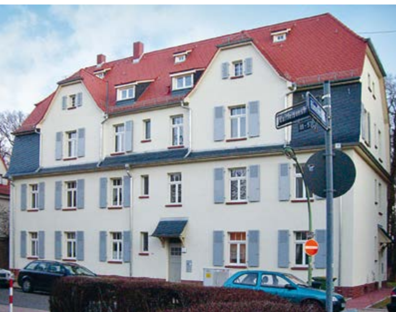
Frankfurt am Main, Stadtteil Riederwald, Raiffeisenstraße, oben vor, unten nach der energetischen und denkmalgerechten Sanierung
