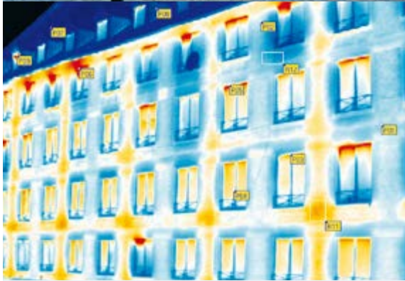
Heilig-Geist-Haus, Hans-Sachs-Platz 1, vor Sanierung
