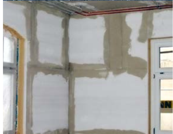
Südstadtforum Qualifizierung und Kultur „südpunkt“, Altbau, Pillenreuther Straße 147/149, während der Sanierung
