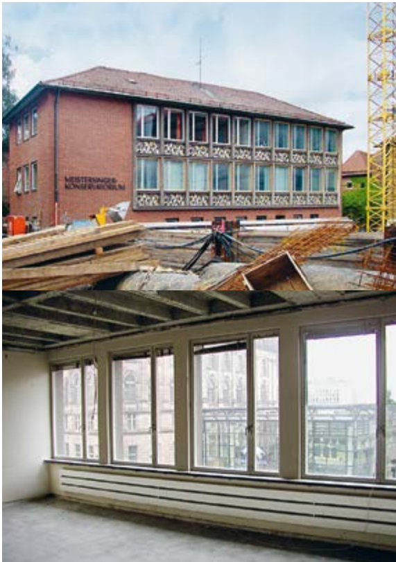
Stadtbibliothek, Am Katharinenkloster 6, während der Sanierung
