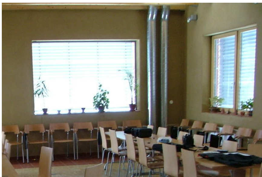
Obrázek 8.5: Vzhled jihovýchodního rohu budovy Centra v Hostětíně ve dne. Svislá pozinkovaná potrubí slouží pro případnou cirkulaci vzduchu mezi sálem a podkrovím, pro využití solárních zisků a chlazení podkroví. (viz text str. 61)
