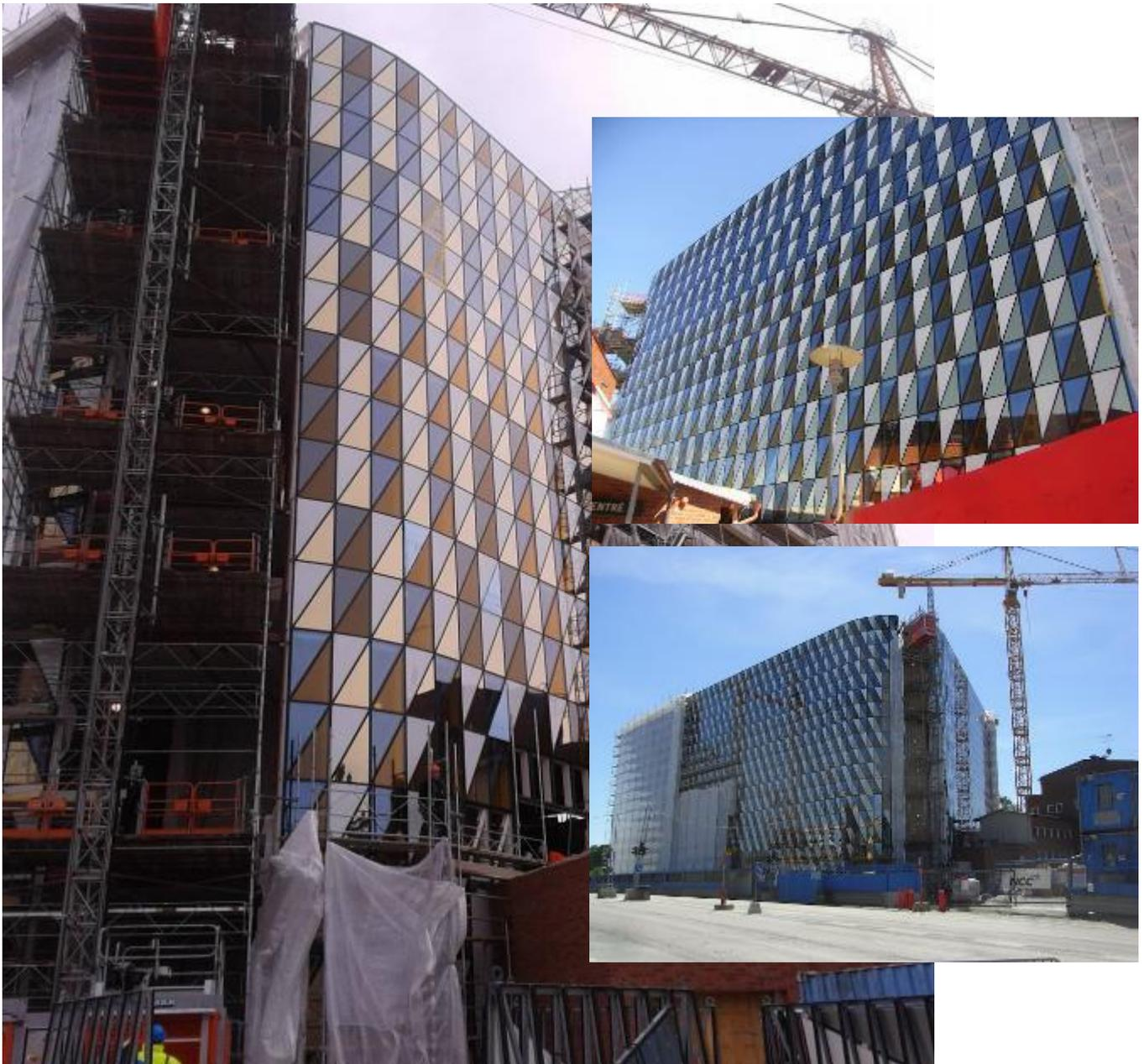
Das in Schweden errichtete Gebäude hat hinter jeder dreieckig ausgebildeten Glasplatte als Wärmedämmung ein Vakuumdämmpaneel von Variotec.
