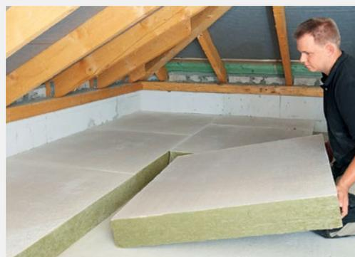
Abb. 22 Dämmung der obersten Geschossdecke
