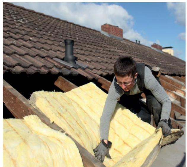
Abb. 24 Dachdämmung von außen – Insbesondere der Anschluss von Außenwand zu Dach wird häufig von außen gedämmt.
