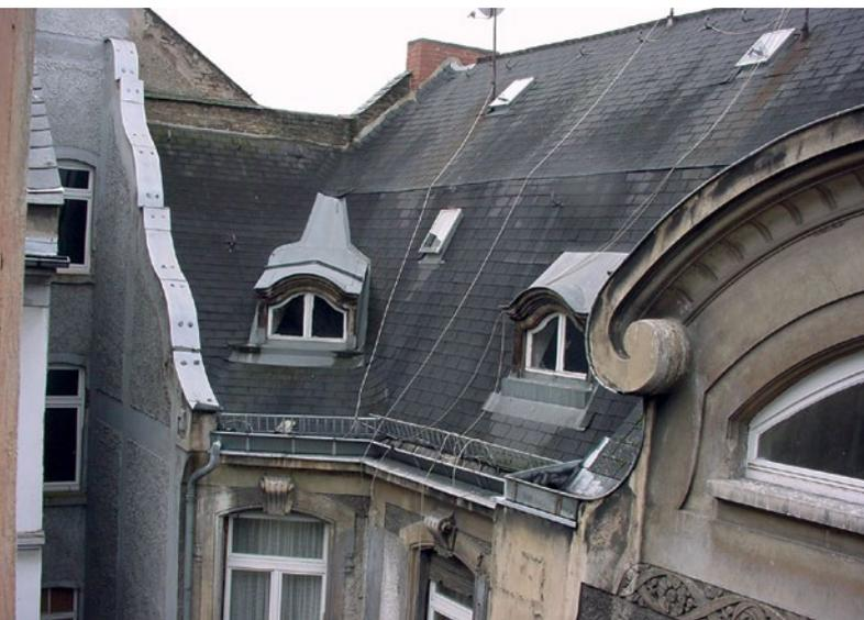
Abb. 23 Kleine Schwalbacher Straße – Eine aufwendige Gestaltung des Dachanschlusses macht eine Aufsparrendämmung bisweilen unmöglich.
