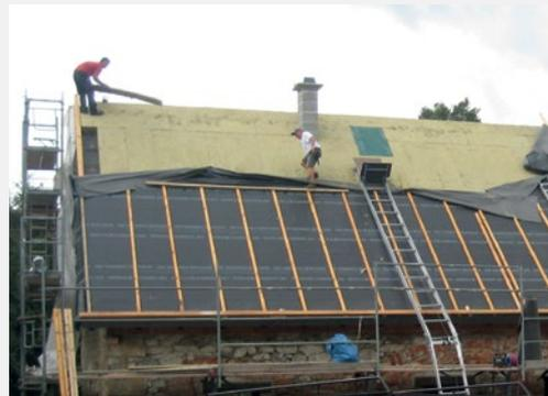
Abb. 21 Dachdämmung von außen
