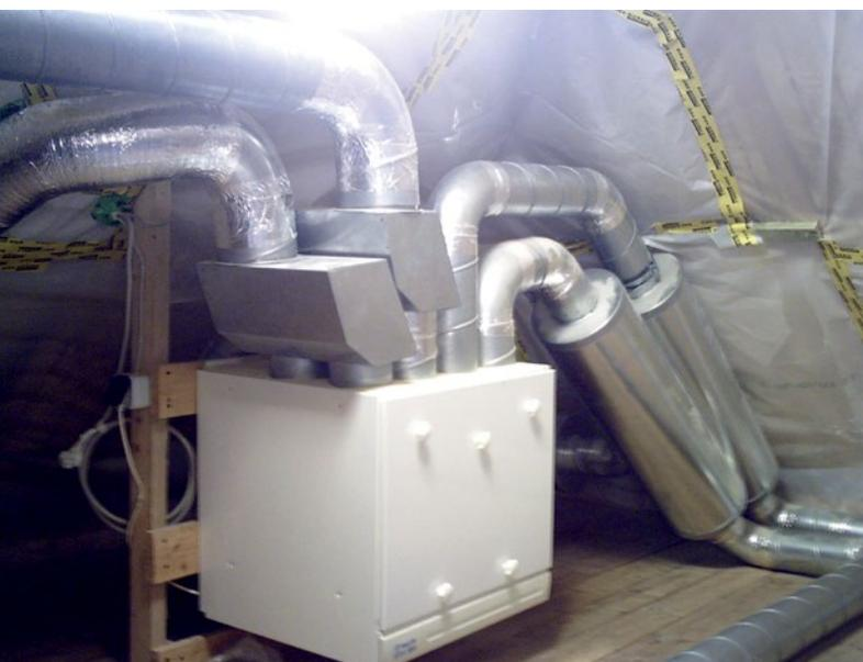
Abb. 86 Komfortlüftung Außenluft und Fortluft über das Dach
