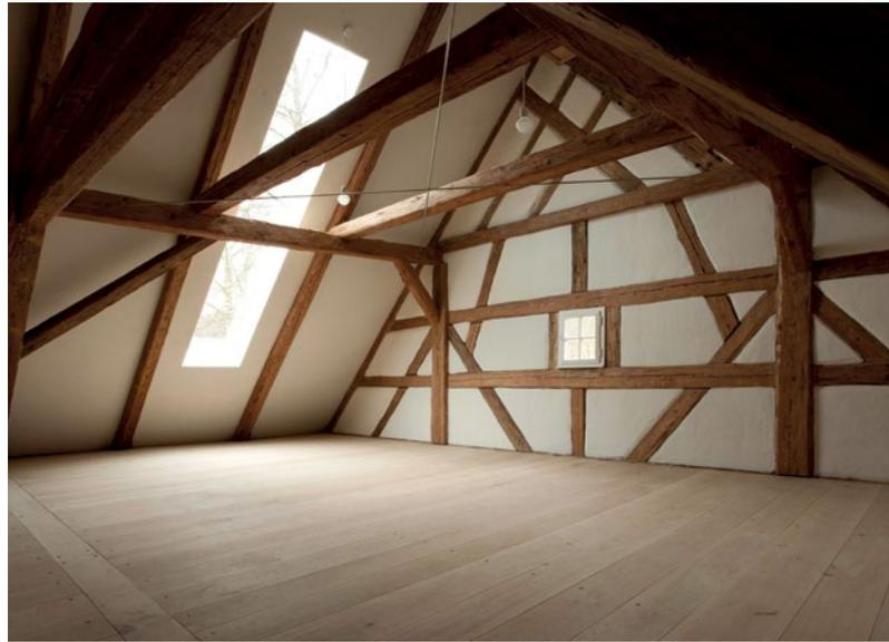
Abb. 25 Sanierung eines Dachwerks mit Aufsparrendämmung und Ausbau zum Wohnraum
