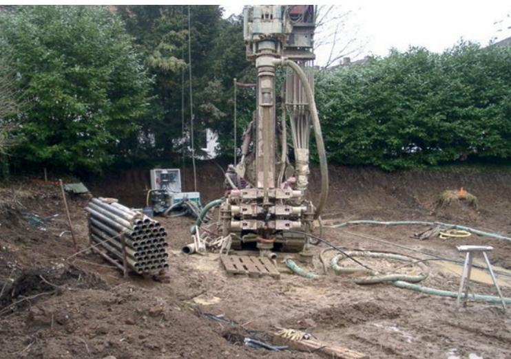
Abb. 74 Erdbohrung für eine Wärmepumpe
