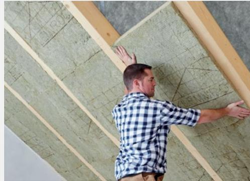
Abb. 20 Einbringen der Dämmung von innen
