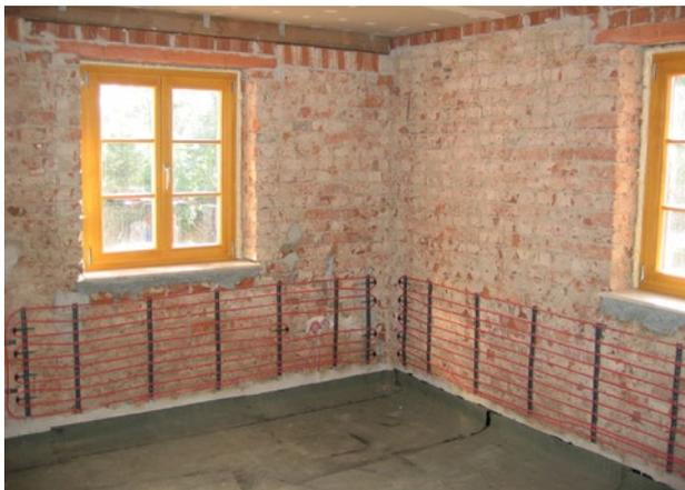
Abb. 77 Einbau einer Wandheizung vor Ziegelmauerwerk
