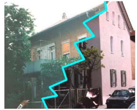
Der Unterschied vorher und nachher ist nicht immer so augenfällig wie bei diesem Haus. Aber immer steigt der (Wohn-)Wert durch eine wärmetechnische Sanierung der Außenwand deutlich!
