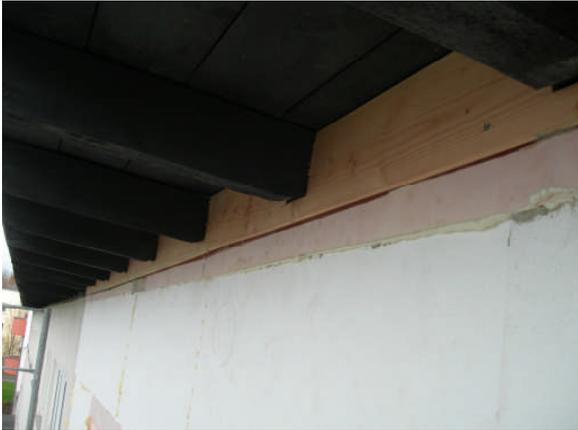
Anschluss angepasste Firstschalung
