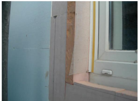
Anschluss VIP/ Phenolharzdämmung im Bereich Fenster
