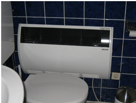
Foto: Fraunhofer IBP, Dr. Andrea Schneider Abbildung 44: Wandkonvektor (ohne Gebläse). Die Raumtemperatur kann bei diesem Gerät zwischen 5 °C und 30 °C stufenlos eingestellt werden.
