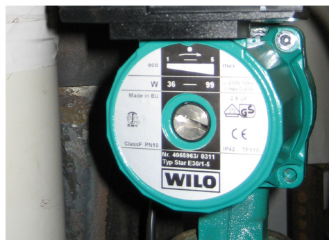
Abbildung 26: Elektronisch geregelte Pumpe. Die Leistung wird je nach Anforderung über die Drehzahl selbstständig geregelt (im dargestellten Beispiel 36 bis 99 W). Da die Heizungsanlage häufig im Teillastbereich arbeitet, muss eine geringere Wassermenge umgewälzt werden.
