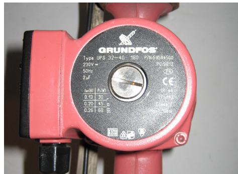
Abbildung 25: Mehrstufige Pumpe. Auf Stufe 1 beträgt die Leistungsaufnahme der beispielhaft dargestellten Pumpe 30 W, auf Stufe 3 bereits 60 W
