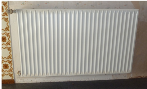
Foto: Fraunhofer IBP, Andrea Schneider Abbildung 15: Plattenheizkörper
