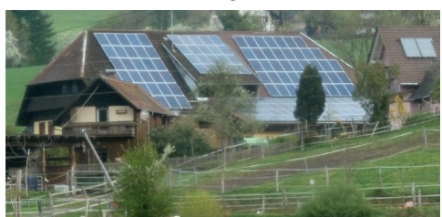
Foto: Fraunhofer IBP, Andrea Schneider Abbildung 50: Photovoltaikanlagen auf dem Dach eines Bauernhauses
