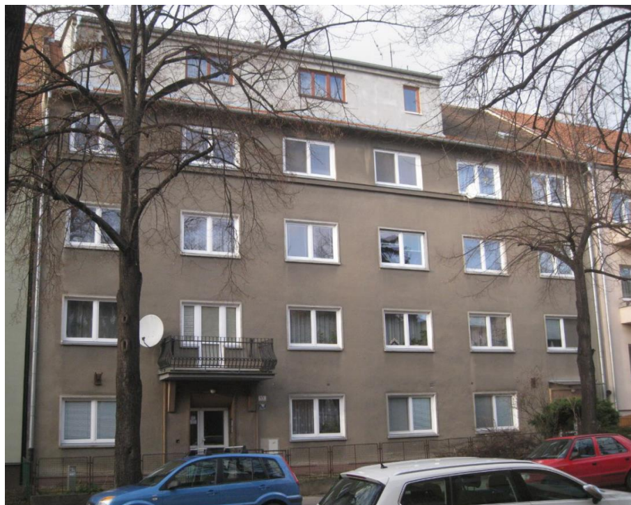
Bytový dům Brno Krkoškova 44 a 44a
