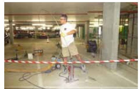
Injektionen bis in eine Tiefe von -4m ab UK Einstellhallen-Boden
