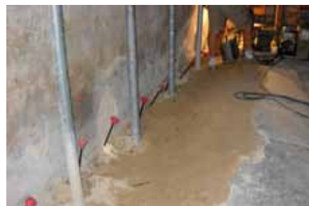
Injektions-Rohre mit Schutz-Kappen
