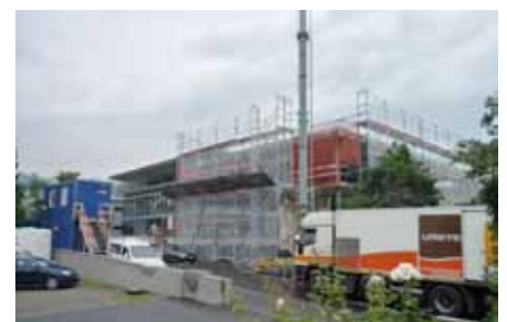
Aufstockung eines Gebäudes um 2 Etagen - Injektionen zur Baugrund-Verbesserung
