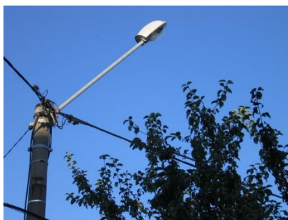
Obrázek 25: Takto NE: Nemělo by docházet k situacím, kdy je svítidlo nakloněné pod úhlem 45° nebo i více. Takový náklon v žádném případě nezajistí lepší osvětlení, ale pouze vyšší světelné znečištění. Téměř vždy takové svítidlo oslňuje. Jedná se o jeden z nejčastějších nešvarů osvětlení zejména na venkově.
