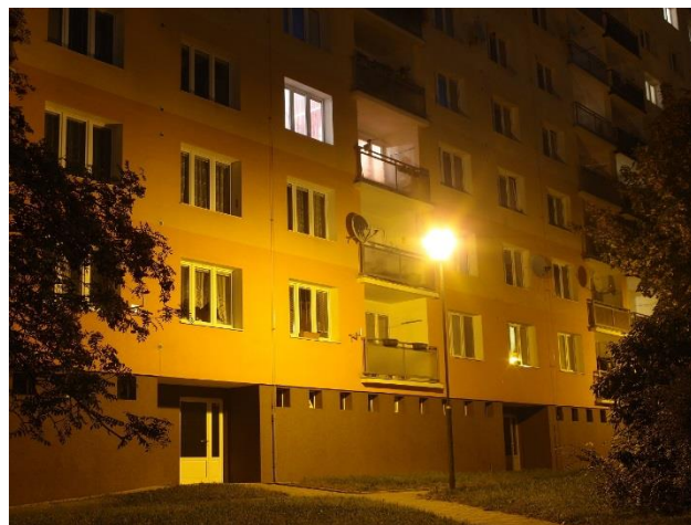
Obrázek 28: Takto NE : Takto by veřejné osvětlení v žádném případě vypadat nemělo. V obou případech jsou použita svítidla, která pro danou situaci nevyhovují svými vlastnostmi ani způsobem instalace.
