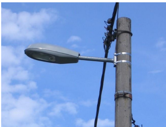
Obrázek 24: Takto ANO: Svítidla by měla být instalována vodorovně. S problémem nevhodně umístěných sloupů daleko od silnice se dá vypořádat použitím delších výložníků. Pak není nutné naklánět samotná svítidla. Na pravém obrázku si však lze všimnout osvětlené fasády rodinného domu – to by se u dobrého osvětlení stávat nemělo.
