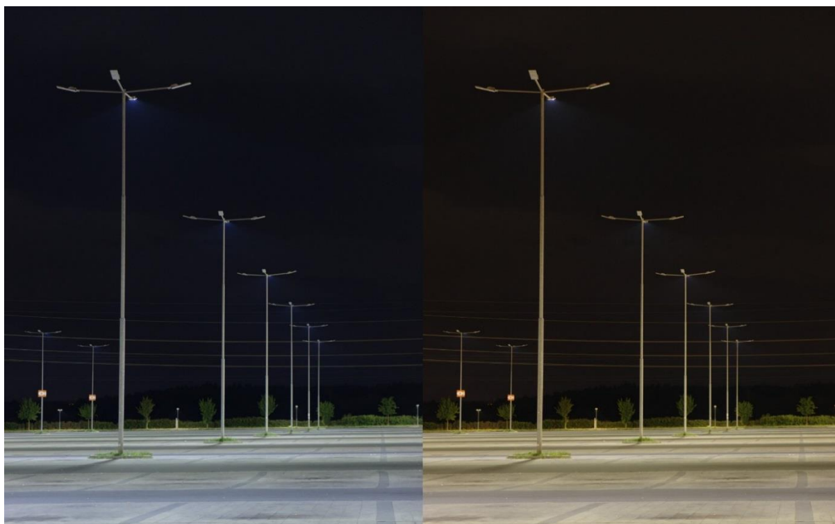
Obrázek 26: Rozdíl mezi LED osvětlením ve studeném (vlevo) a teplém (vpravo) odstínu. Doporučení pro šetrné venkovní osvětlení je držet CCT co nejnižší (pod 3000K), tedy preferovat teplejší odstíny světla.
