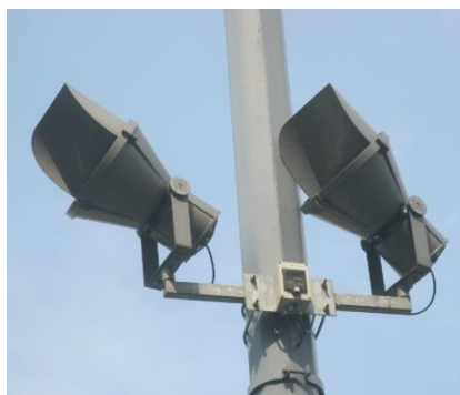
Obrázek 31: Takto ANO: Příklady jednoduchých technických doplňků, které účinně omezují světelné znečištění. Podobné clonky se obvykle dají použít i na již nainstalovaná svítidla. Vlevo jsou světlomety se širokým kuželem světla (flood), vpravo s úzkým kuželem (spot).
