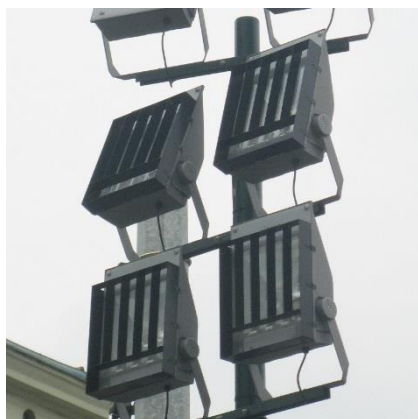
Obrázek 31: Takto ANO: Příklady jednoduchých technických doplňků, které účinně omezují světelné znečištění. Podobné clonky se obvykle dají použít i na již nainstalovaná svítidla. Vlevo jsou světlomety se širokým kuželem světla (flood), vpravo s úzkým kuželem (spot).
