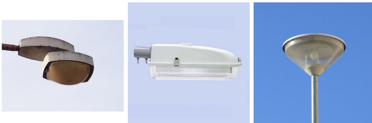
Obrázek 22: Takto NE: zastaralá a znečištěná svítidla, stejně jako svítidla bez kvalitní optiky usměřující světlo pouze dolů, nevyhovují požadavkům na šetrné osvětlení.
