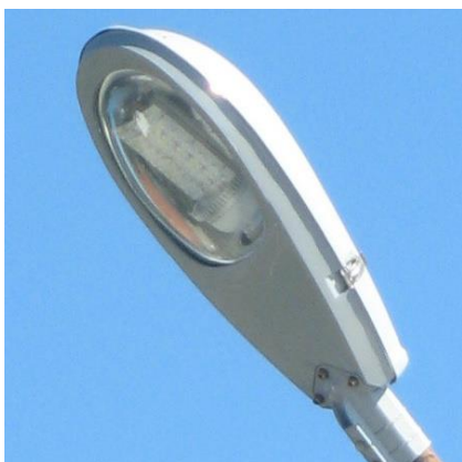
Obrázek 27: Takto NE (vlevo); Takto ANO (vpravo). LED by měly být vždy ve speciálním svítidle přímo pro ně určeném (vpravo), jen tak lze zajistit kvalitní osvětlení a nízkou míru světelného znečištění. Do výbojkových svítidel (vlevo) LED nepatří.
