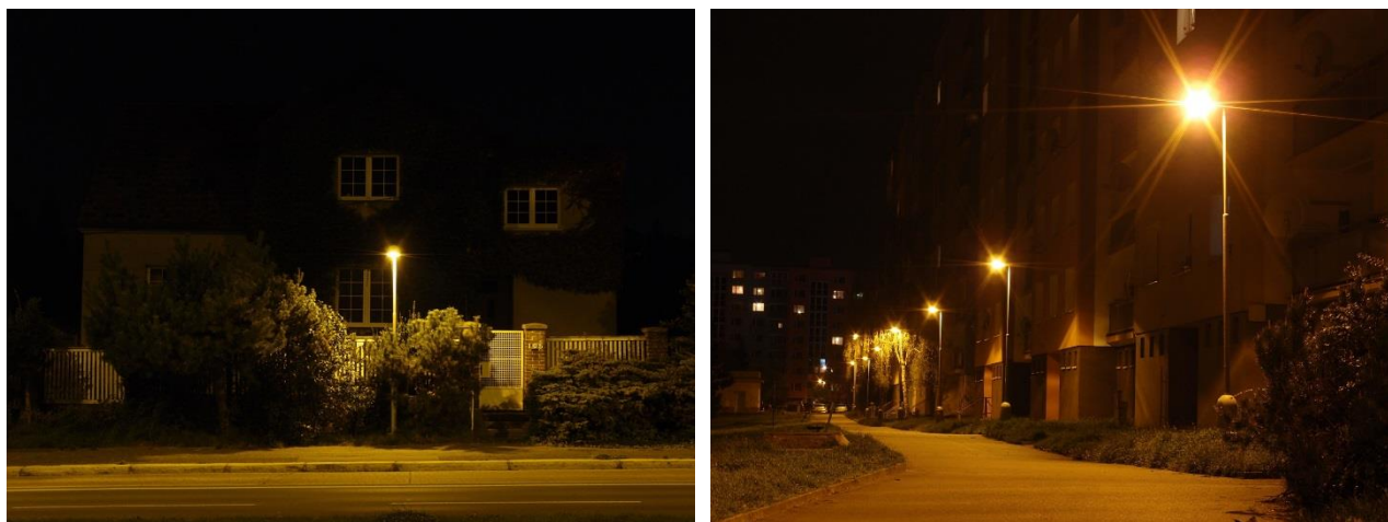
Obrázek 29: Takto ANO : Vhodná, správně nainstalovaná svítidla umožňují dobře osvětlit chodník před domem, aniž by obtěžovala obyvatele. V obou případech svítidla splňují požadavky specifikované v bodech 1) a 2).
