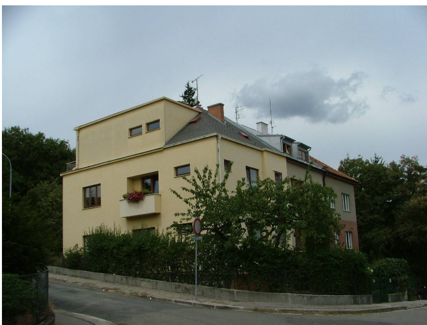
Další místní dům se šikmou střechou, u nějž jsou zdi zakončené nahoře jen okapy:
