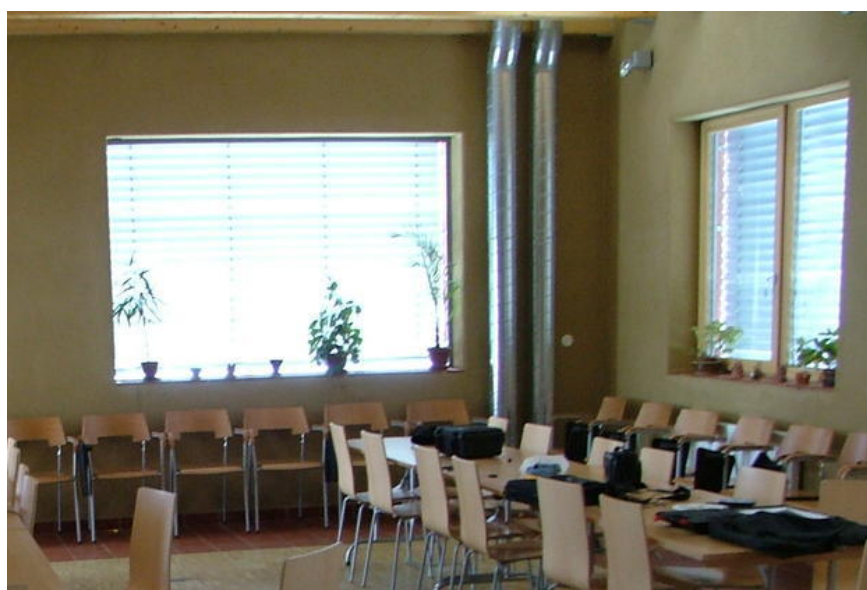
Obrázek 8.5: Vzhled jihovýchodního rohu budovy Centra v Hostětíně ve dne. Svislá pozinkovaná potrubí slouží pro případnou cirkulaci vzduchu mezi sálem a podkrovím, pro využití solárních zisků a chlazení podkroví. (viz text str. 62)
