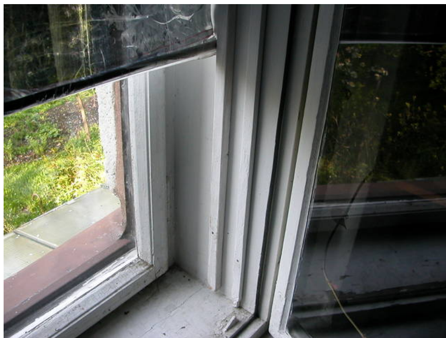
Obrázek 8.3: Dvě lišty na boku starého dvojitého okna spolu se dvěma roletami z pokovené fólie sníží na noc koeficient prostupu tepla až na U = 0,6 \text{ W}/(\text{m}^2\text{K}) . (viz text str. 48)
