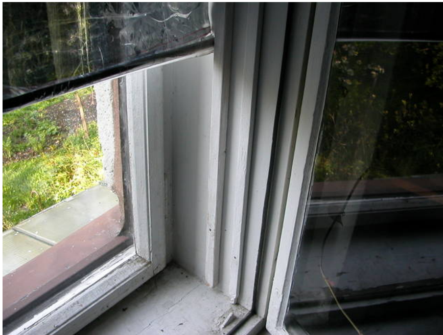
Obrázek 8.3: Dvě lišty na boku starého dvojitého okna spolu se dvěma roletami z pokovené fólie sníží na noc koeficient prostupu tepla až na U = 0,6 \text{ W}/(\text{m}^2\text{K}) . (viz text str. 47)
