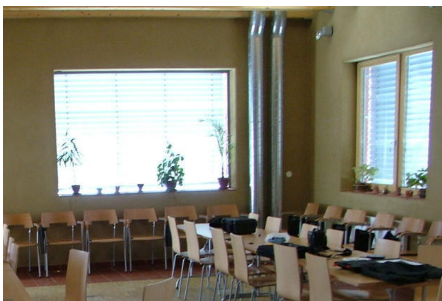
Obrázek 8.5: Vzhled jihovýchodního rohu pasivní budovy Centra Veronica Hostětín (dále jen Centrum v Hostětíně) ve dne. Svislá pozinkovaná potrubí slouží pro případnou cirkulaci vzduchu mezi sálem a podkrovím, pro využití solárních zisků a chlazení podkroví. (viz text str. 61)
