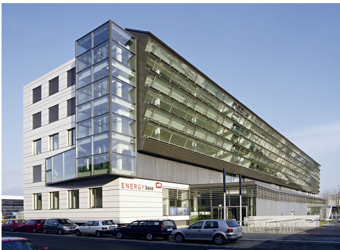
Obr.: Budova EnergyBase má jižní okna skloněná dolů, nad nimi jsou naopak dobře osluněné PV panely
