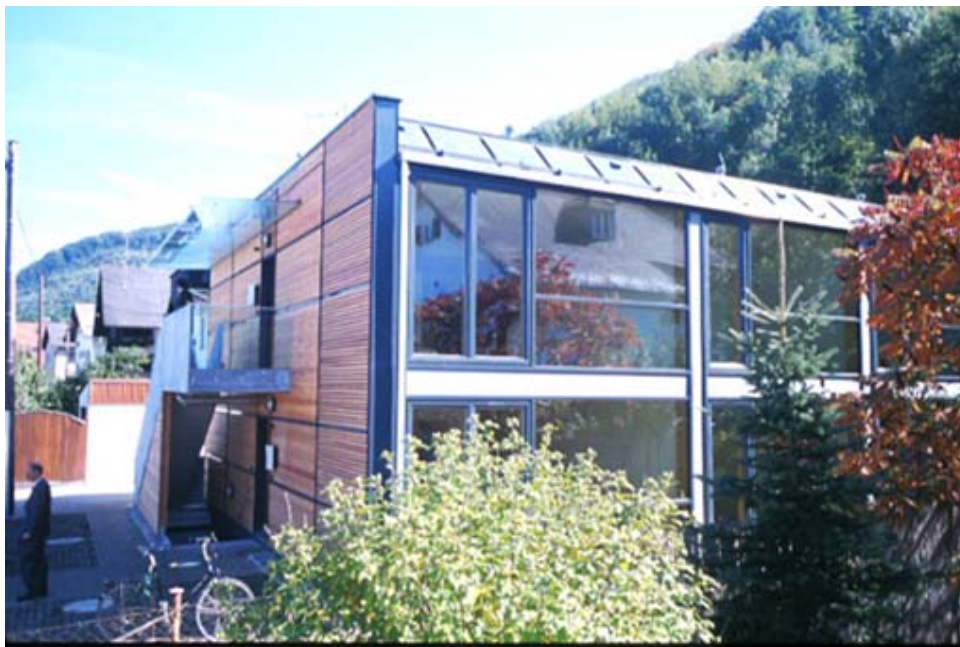
Pasivní bytový dům v Salzburgu
