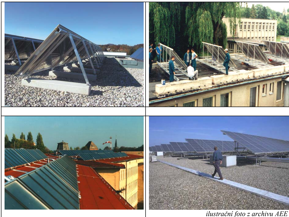
obr. 13. Příklady instalac íkolektorů na vlastní konstrukci
