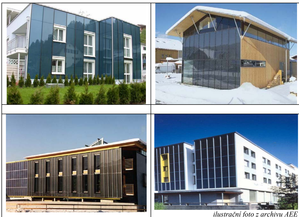
obr. 14. Příklady instalací fasádních kolektorů
