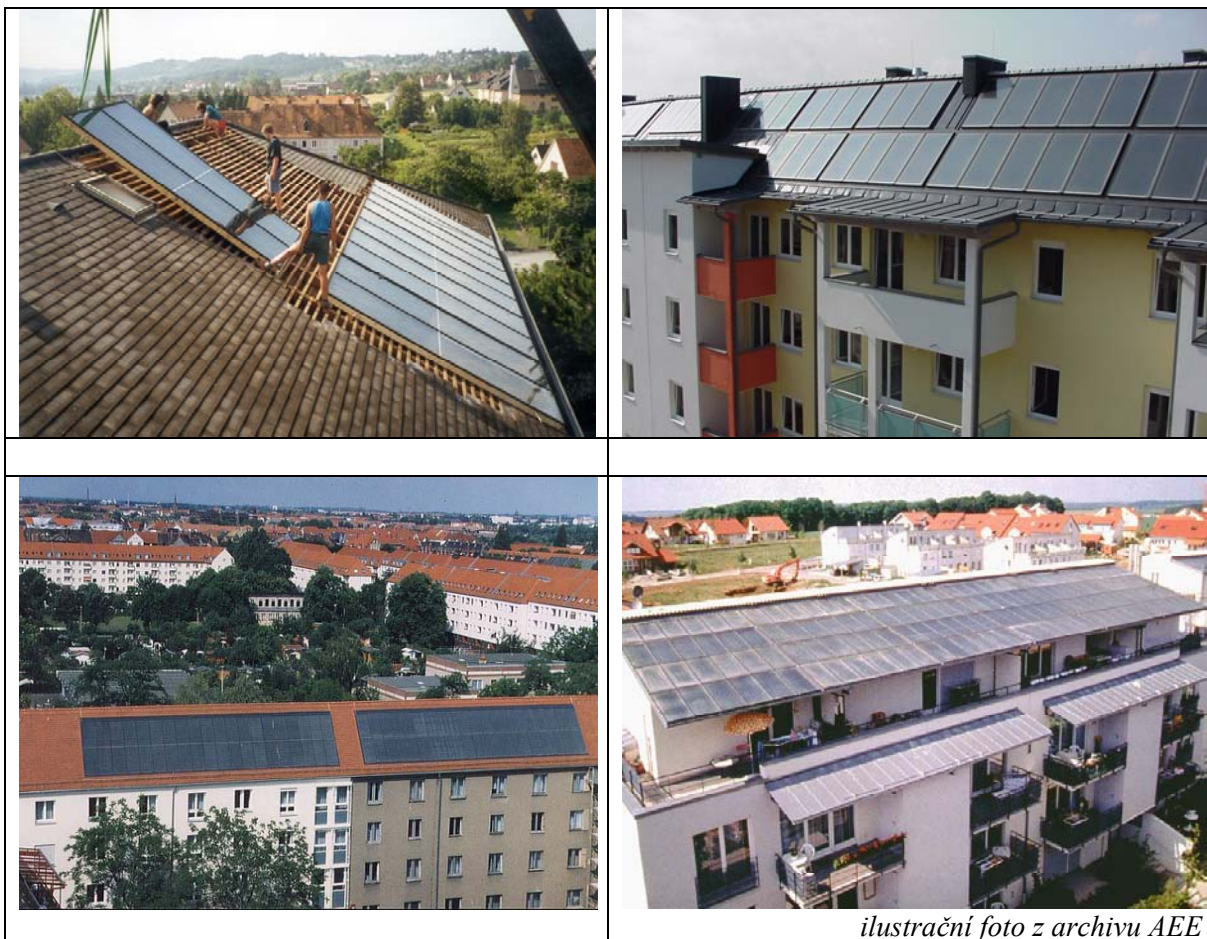
obr. 12. Příklady instalací kolektorů integrováním do střešní krytiny
