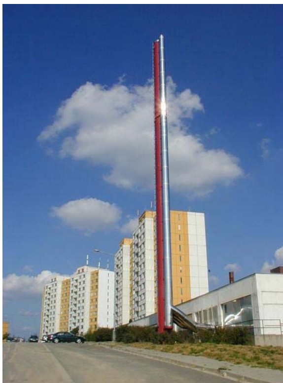
obr. 19. Kotelna na spalování biomasy v Brně - Bystrci
