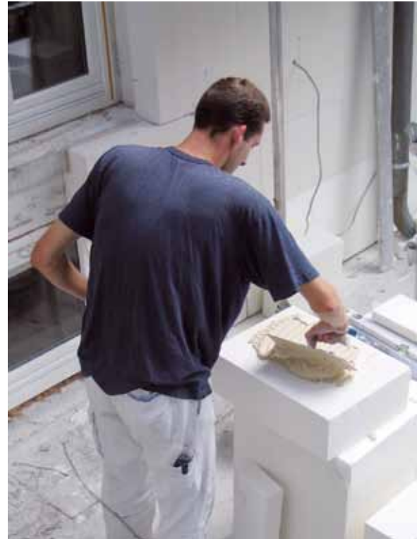
Mineraldämmplatten für ein Altbremer Haus.
