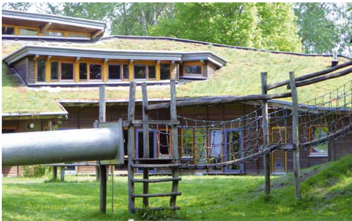
Begrüntes Dach: Grundschule Auf den Heuen.
