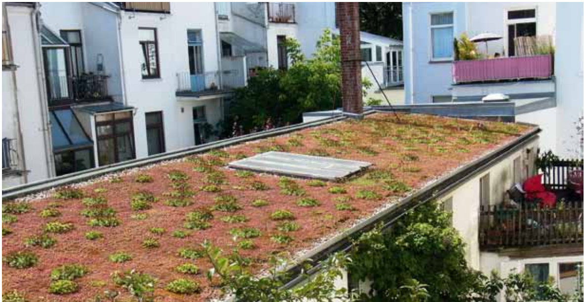
Geförderte Dachbegrünung (Kapitel 4.2) auf einer typischen Bremer Innenhofbebauung.
