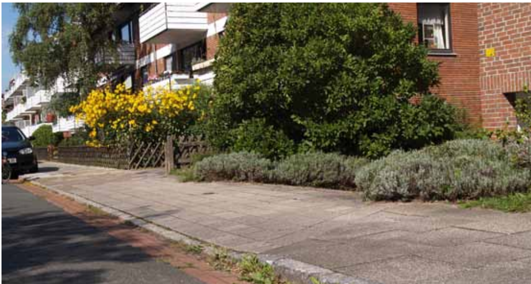
Bodenschwelle vor einer Tiefgarage.
