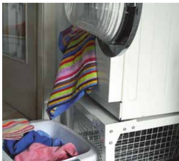
Waschmaschine auf Metallsockel.
