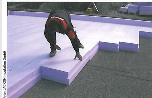
Perimeterdämmung auf Basis von JACKODUR® KF mit dem Schalungssystem JACKODUR® Atlas.
