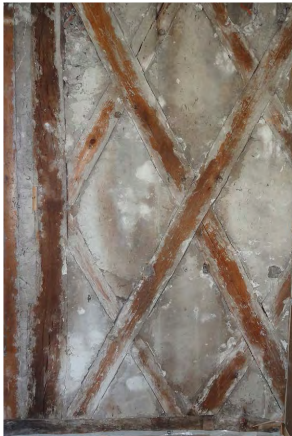
Aussenwand von 1690, Ansicht der raumseitig verputzten Gefache nach der Demontage der Täfer (Abb. 72)
