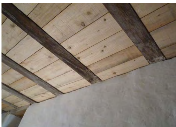
Gossau, Allenwinden, sorgfältig gedämmte Kellerdecke (Abb. 43)
