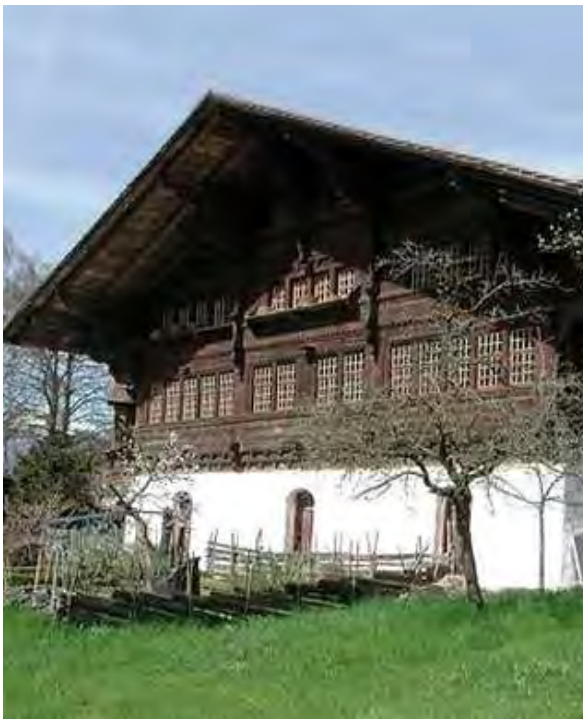
Alpiner Blockbau, Agensteinhaus in Erlenbach i. S., erbaut 1766 (Abb. 68)
