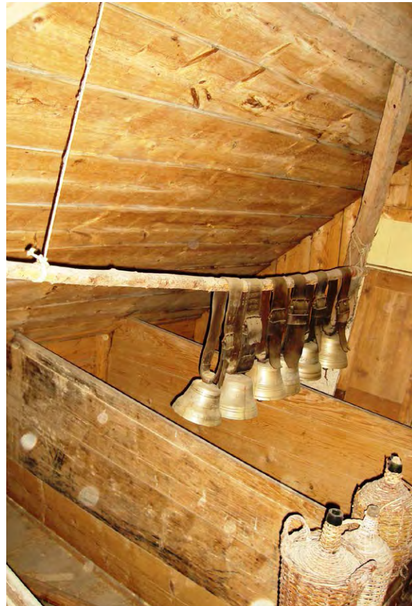
Berner Wohnstock, brettverschalter Dachraum mit Kornkästen (Abb. 84)
