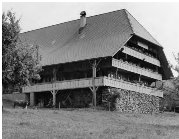
Wahlern, Bauernhof Aeckenmatt, 1746, grosse Dachvorsprünge und Lauben als Sonnen- und Wetterschutz eines Skelettbaus aus Holz (Abb. 19)
