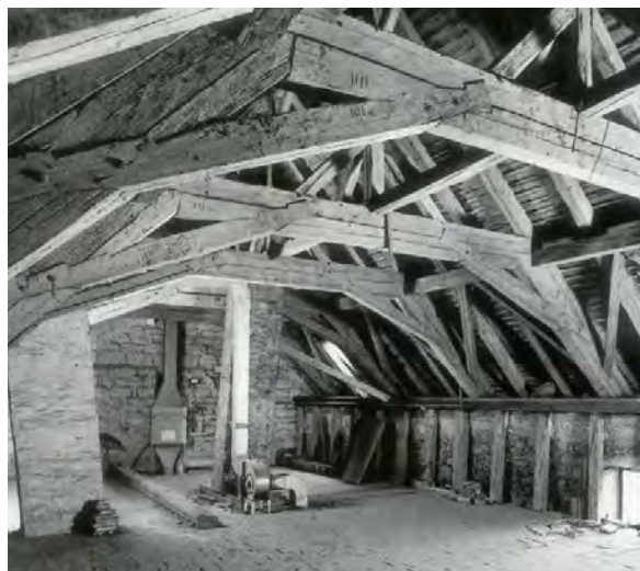
Wertvoller Dachraum des Schloss Murten mit zweifach liegendem Sparrendachstuhl und Dachboden mit Tonplatten belegt (Abb. 82)
