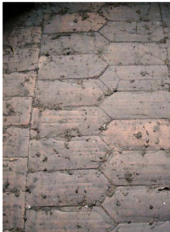
Tonplatten, Dachboden eines herrschaftlichen Wohnhauses, um 1690 (Abb. 85)
