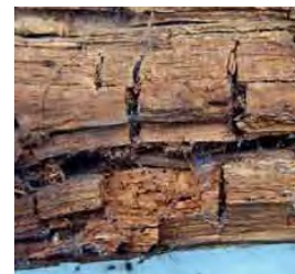
Kellerschwamm, fächerförmiges Mycel (Abb. 13); Balkenoberfläche: braunfaules Würfelbruchbild (Abb. 14)
