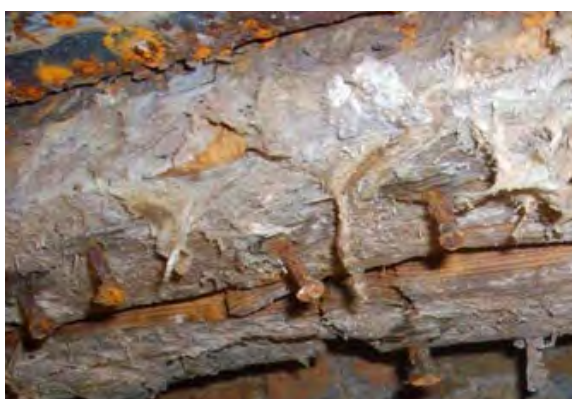
Hausschwamm, Mycel und Fruchtkörper (Abb. 12)
