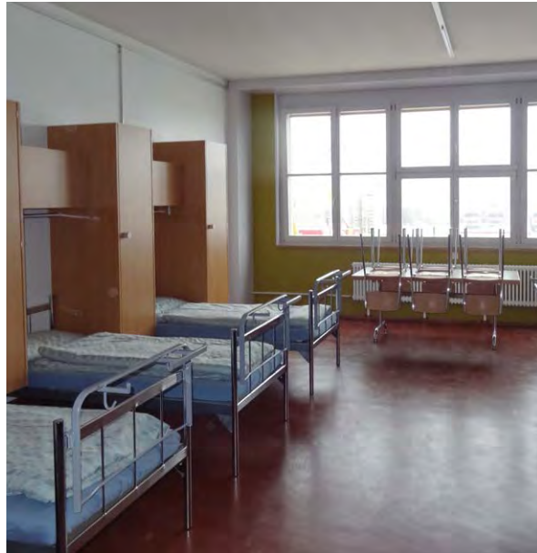
Dufourkaserne Thun, Sichtbetonbau, innen gedämmt mit 80 mm Schaumglas und mit Kragen für Decken- und Trennwandanschlüsse (Abb. 57)
