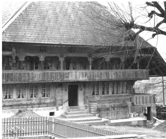
Staldenhof in Oberburg, hervorragender Ständerbau von 1772 (Abb. 69)
