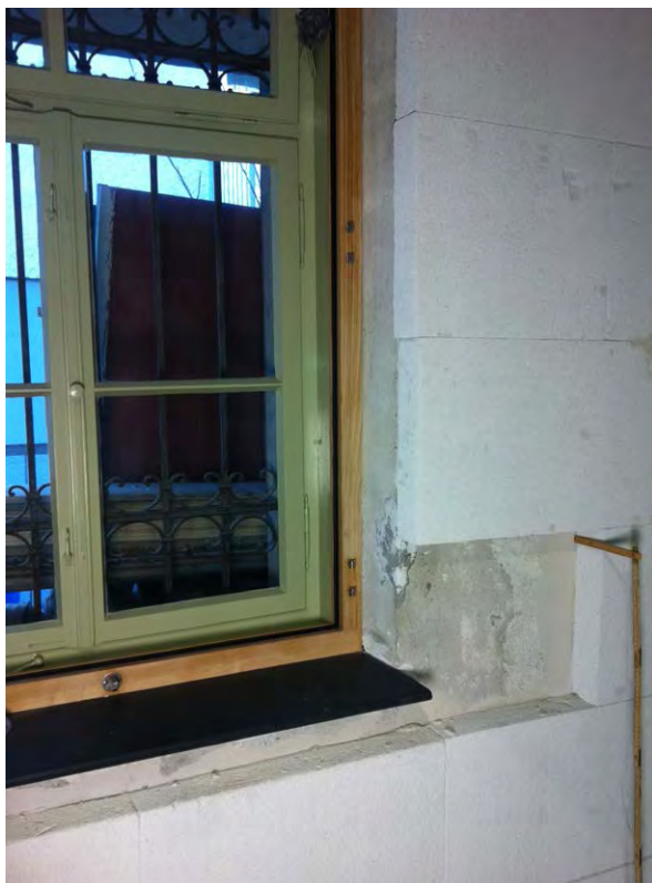
Reduzierte Innendämmung mit mineralischen Dämmplatten (Abb. 59)
