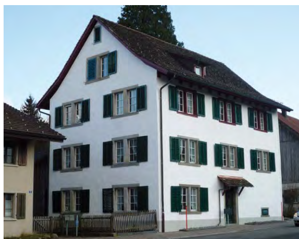
Hittnau (ZH) Pfarrhaus, Aufnahme vor 1942 Sanierung unter den kriegsbedingten Heimatstileinflüssen 1942 Energetische Sanierung mit Dämmputz 2011 (Abb. 63, 64, 65)
