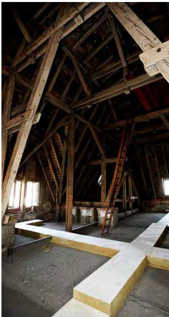
Spezialkonzept mit harter und weicher Dämmung: Willemer Schule Frankfurt von 1908, nicht begehrbar gedämmt, mit begehrbaren, hartgedämmten Wegen (Abb. 89)
