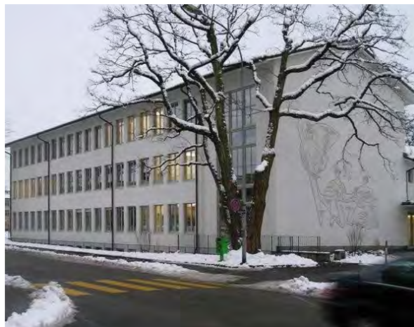
Schulhaus Kreuzfeld, Langenthal, erbaut 1951 durch Walter Schwaar. Energetisch saniert nach reduziertem kombinierten Konzept (Abb. 67)
