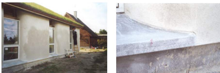
Figur 32. Ungdomsboliger i Torup, Nordsjælland. Her er buede udvendige vindueslysninger medvirkende til godt lysindtag. Den støbte betonsålbænk og opkanten langs med den buede vindueslysning beskytter pudsen mod fugt.
