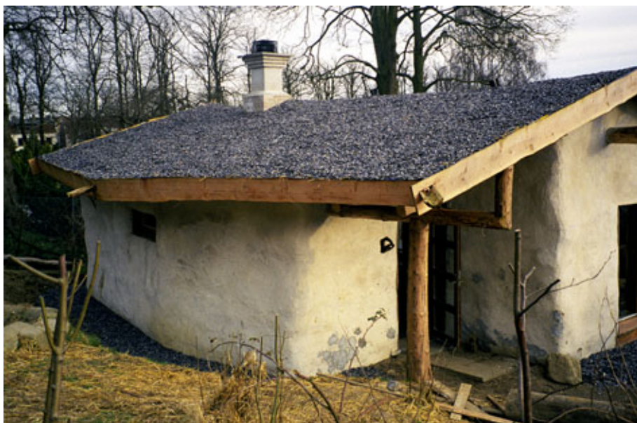
Figur 53. Ud over anvendelse som isoleringsmateriale i vandrette konstruktioner anvendes muslingeskaller som tagdækning. Daginstitution i Horsens.
