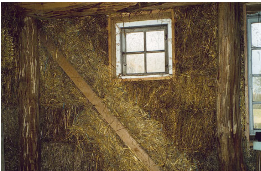
Figur 19. Halmhus ved Præstø. Afstivning med skrâbånd af tømmer.
