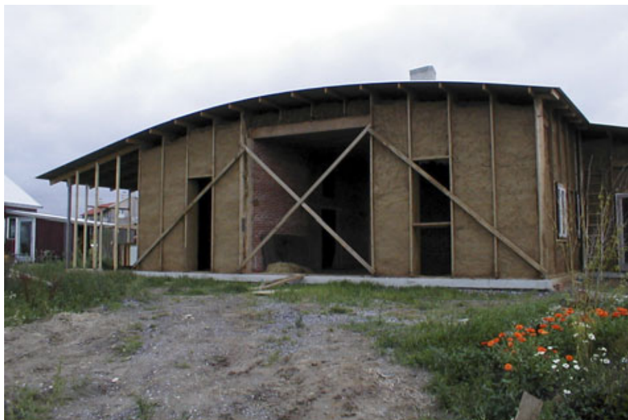
Figur 2. Halmhus i Herskind ved Århus under opbygning. Her ses det bærende træskelet udfyldt med halmballer. Afstivning af gavle er midlertidig. (Foto: Lars Keller).
