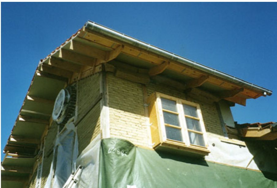
Figur 4. Halmhus i Torup. Bagmuren er opbygget som en bindingsværkskonstruktion udfyldt med lersten. Udvendig er efterfølgende isoleret med halmballer. Indvendig lerpudset og udvendig pudset med kalkcementmørtel.
