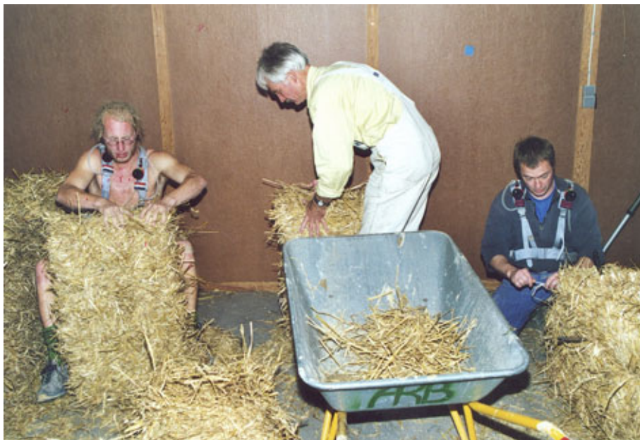
Figur 54. Tildannelse og syning med bindegarn.
