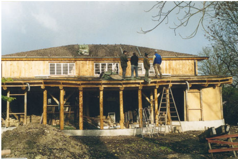
Figur 13. Halmhus i Agerup ved Næstved opført i 2002 af selvbyggere. Byggeriet er inspireret af tyske ler- og halmbyggeteknikker. Der er fx fremstillet lerhalmplader på stedet til indervægge, og i etageadskillelsen er der anvendt lyddæpende viklere (ler snoet omkring lægter).
