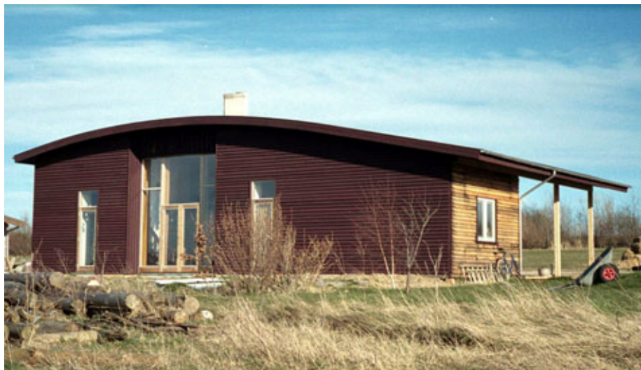
Figur 1. Halmhus i Herskind ved Århus. Huset er opført i 2001 af professionelle håndværkere. Udenpå de lerpudsede halmvægge er opsat en regnskærm af brædder på klink. Stålblader er anvendt som tagdækning, og hensigten er, at der skal græs på taget. (Foto: Jettie Nielsen).
