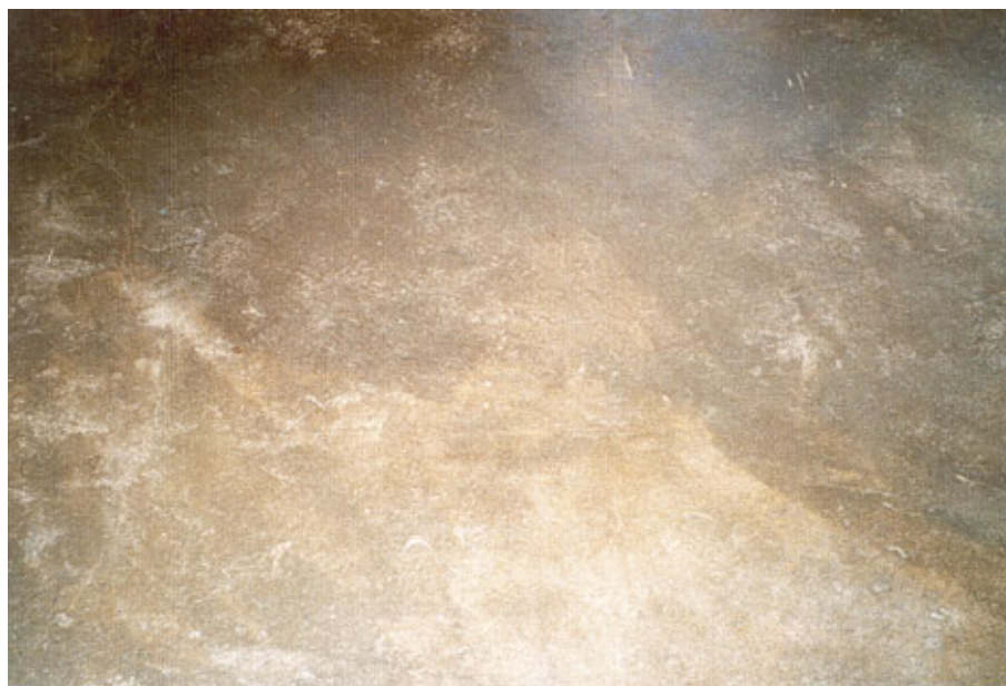
Figur 28. Gulvoverflade i ler tilsat linolie og hestemøg. Halmhus på Sydøen.
