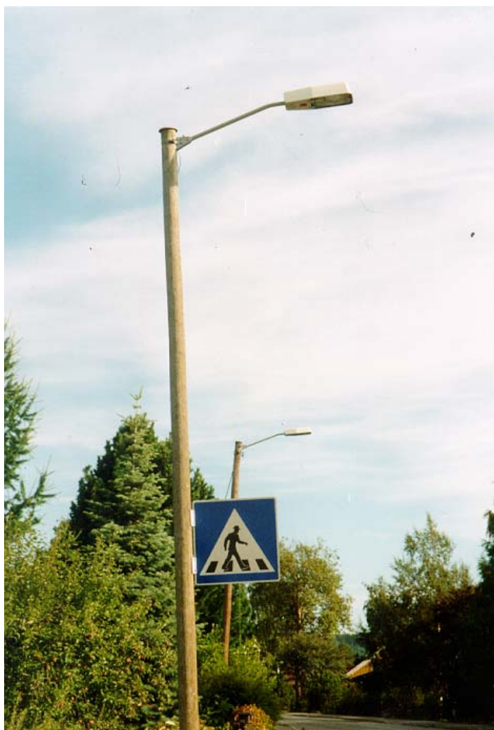
Původně plně cloněná svítidla na dřevěných sloupech na stráni nad Lillehammerem. Svahové pohyby je během let poněkud naklonily...
