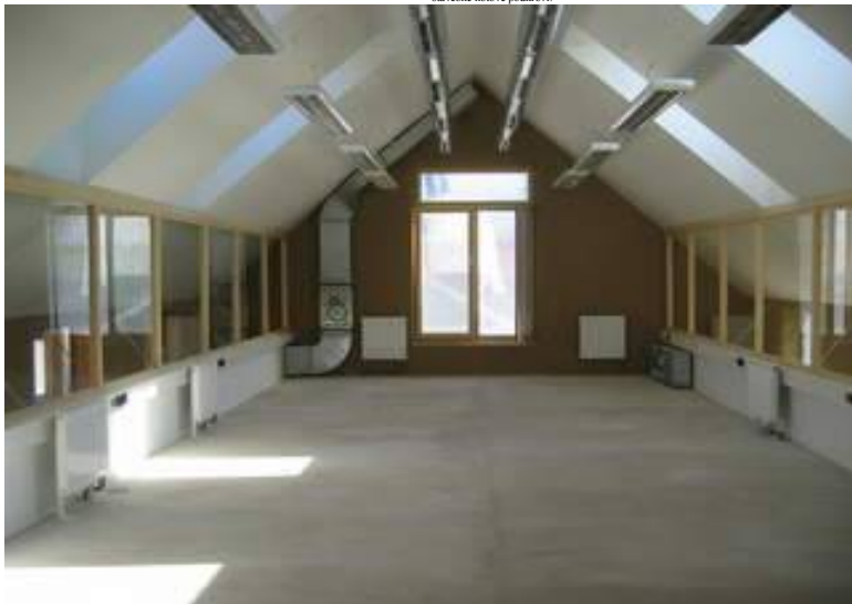
stavebně hotové podkroví:
