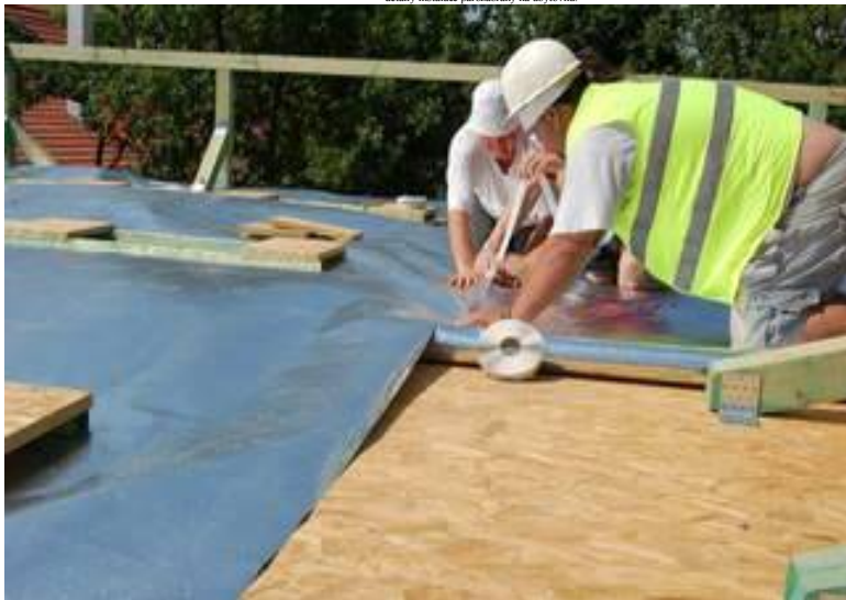
detaily instalace parozábrany na ubytovnu:
