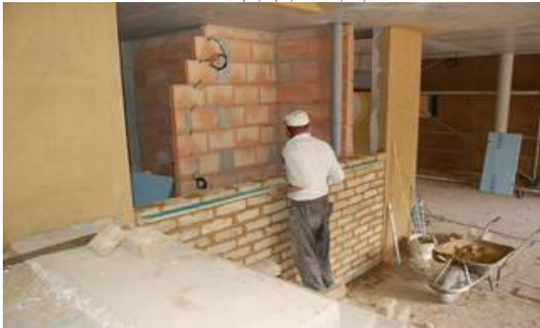
zdění příčky z nepálených cihel mezi foyer a bytovnou:
