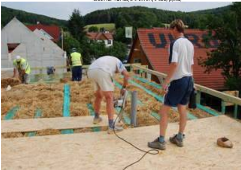
pokládání dvou vrstev slámy na střechu (vrstvy se oddělují papírem):
