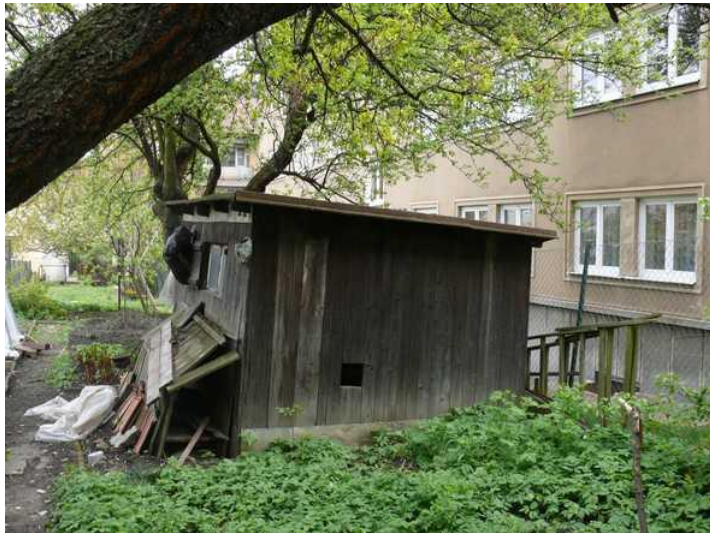
Pozemek p.č. 1541-vedlejší stavba
