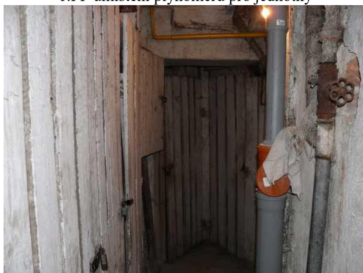
1.PP-sklepy, stupačky kanalizace
