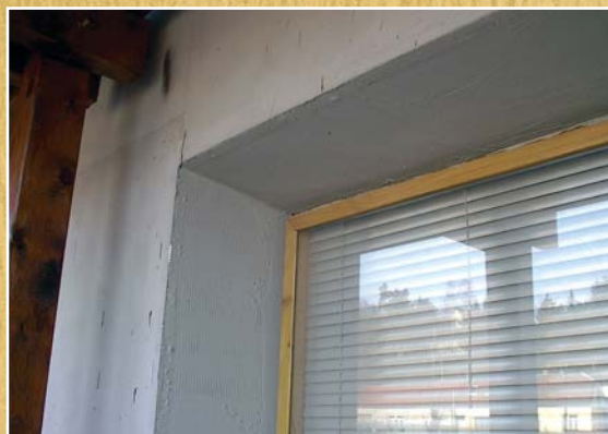
Postup umístění třetího skla a zateplení pohyblivé části rámu. Pevná část rámu je překryta izolací
